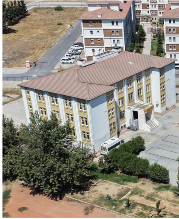
Fotoğraf 11: Aydın İncirliova Spor Lisesi Yurt Binası Çatı
