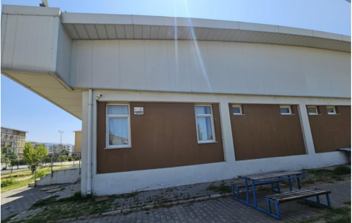
Fotoğraf 14: Nazilli Asımın Nesli Anadolu İmam Hatip Lisesi Spor Salonu Binası Dış Cephe 3
