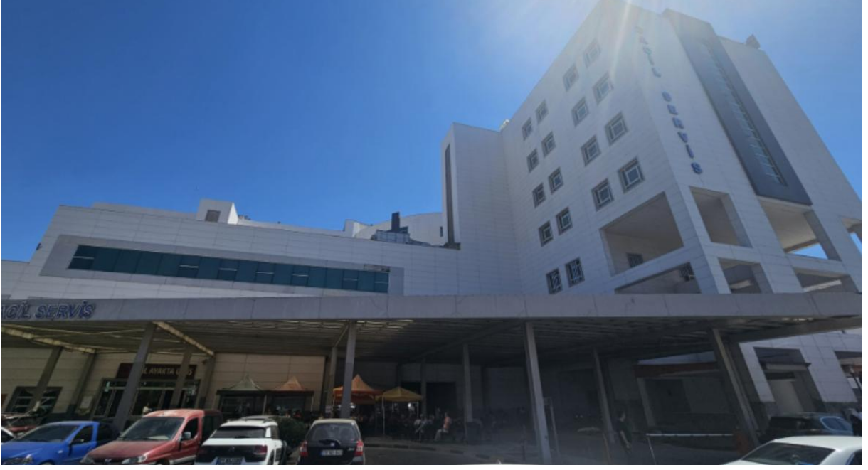
Fotoğraf 3: Nazilli Devlet Hastanesi Binası Dış Cephe 3
