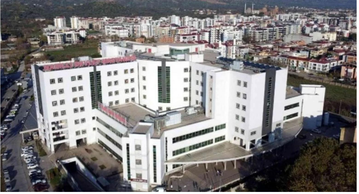
Fotoğraf 5: Nazilli Devlet Hastanesi Binası Çatı 1
