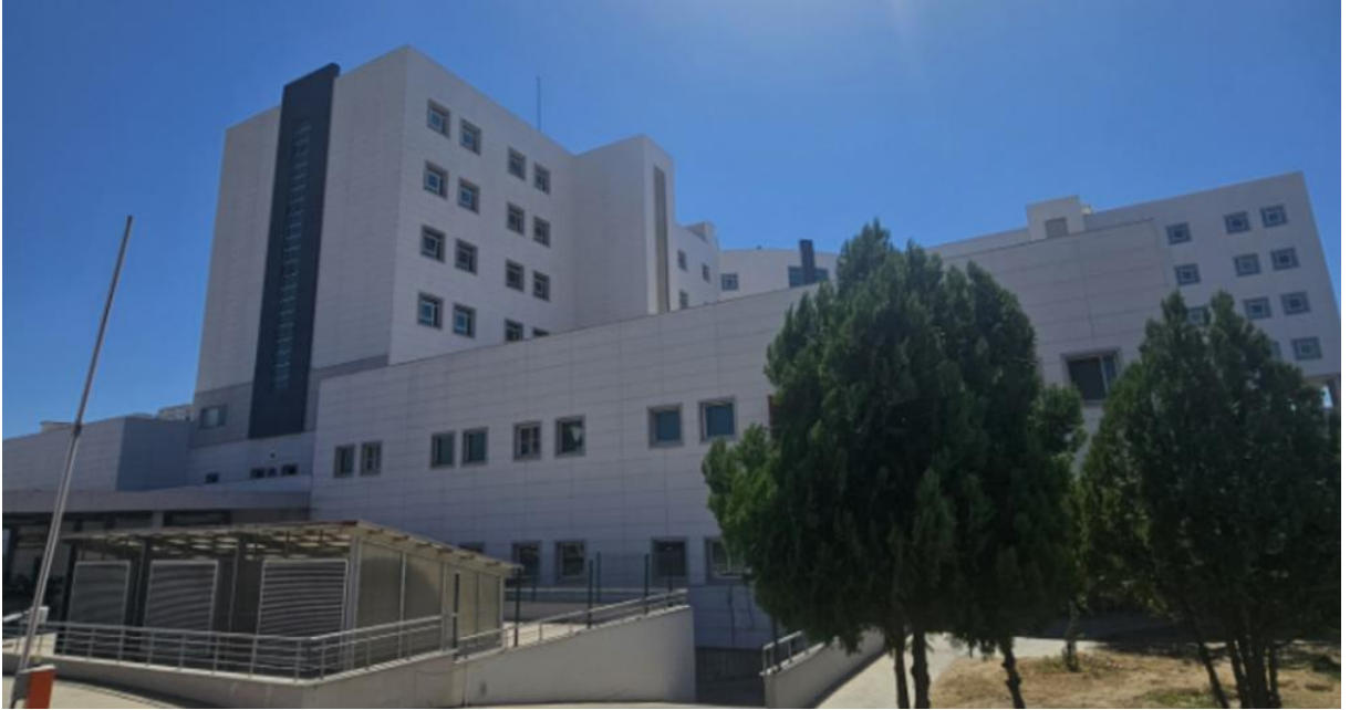
Fotoğraf 2: Nazilli Devlet Hastanesi Binası Dış Cephe 2
