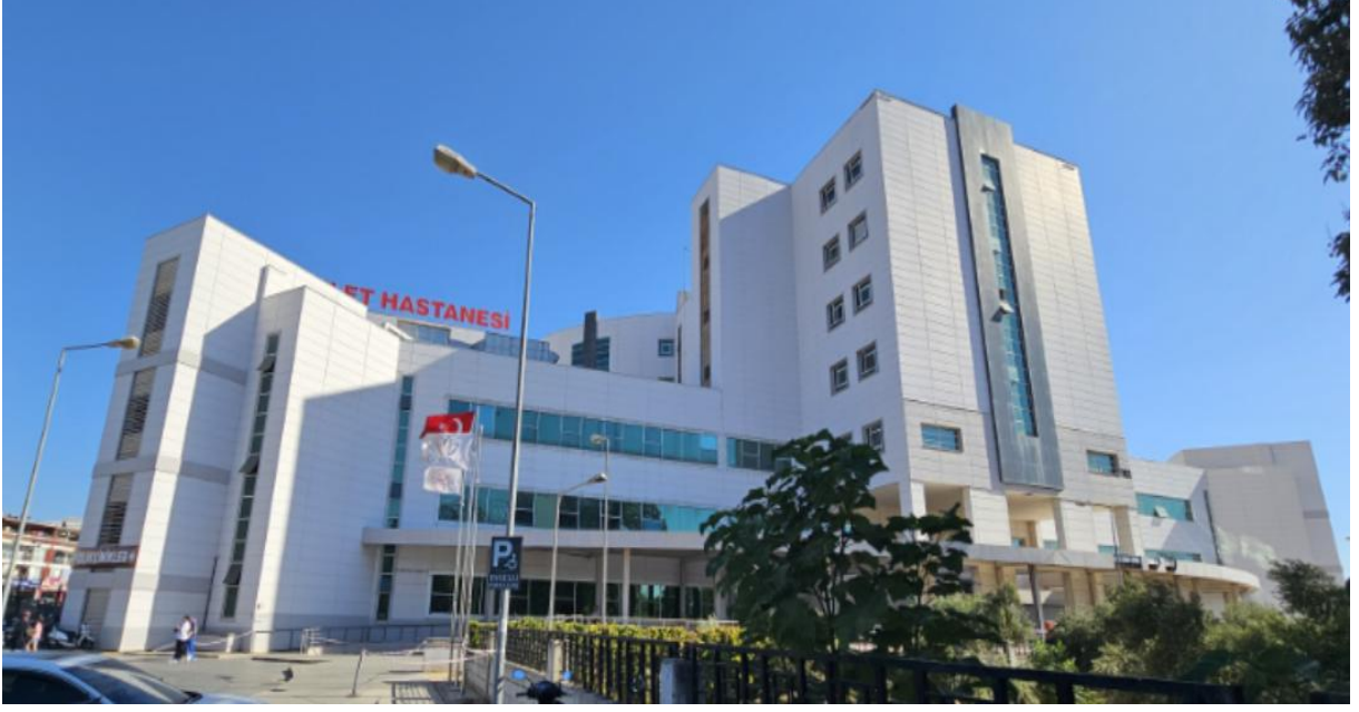
Fotoğraf 1: Nazilli Devlet Hastanesi Binası Dış Cephe 1
