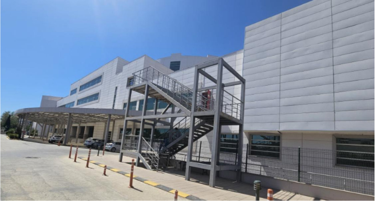
Fotoğraf 4: Nazilli Devlet Hastanesi Binası Dış Cephe 4
