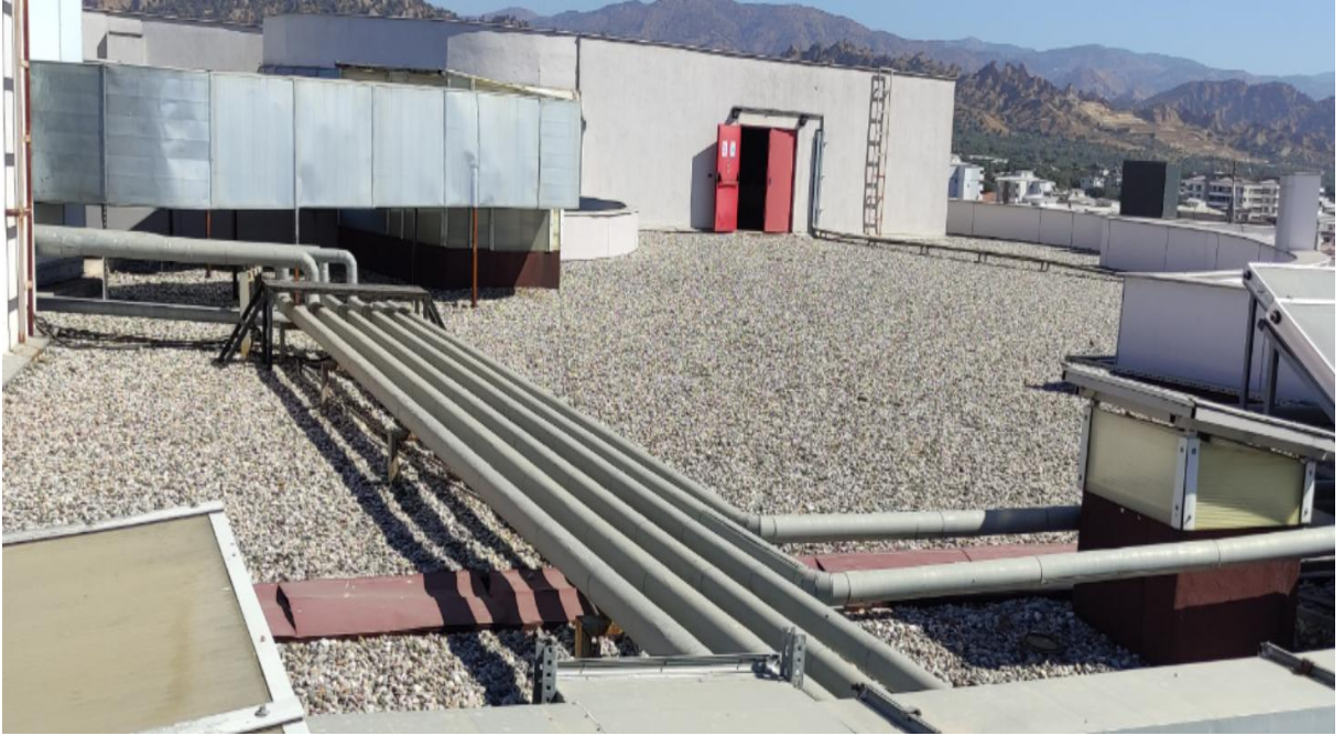
Fotoğraf 6: Nazilli Devlet Hastanesi Binası Çatı 2
