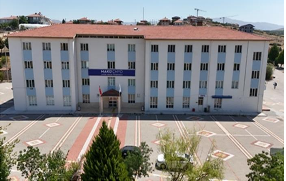
Şekil 7. Mehmet Akif Ersoy Üniversitesi Çavdır Meslek Yüksekokulu Binası
