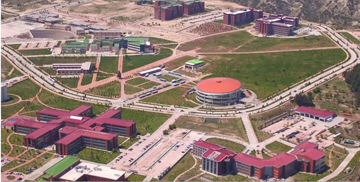
Şekil 1: Mehmet Akif Ersoy Üniversitesi MAKÜ KABEV Projesi Binaları Binalarının Üstten Görünüşü - Uydu Görüntüsü
