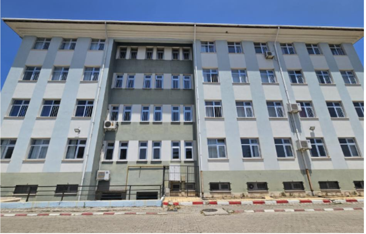
Fotoğraf 3: Nazilli Menderes Anadolu Lisesi Okul Binası Dış Cephe 3
