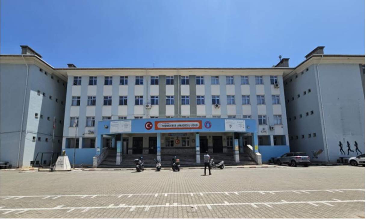
Fotoğraf 1: Nazilli Menderes Anadolu Lisesi Okul Binası Dış Cephe 1
