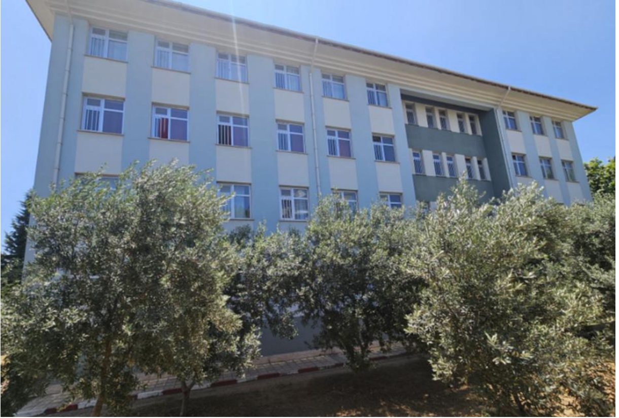
Fotoğraf 4: Nazilli Menderes Anadolu Lisesi Okul Binası Dış Cephe 4
