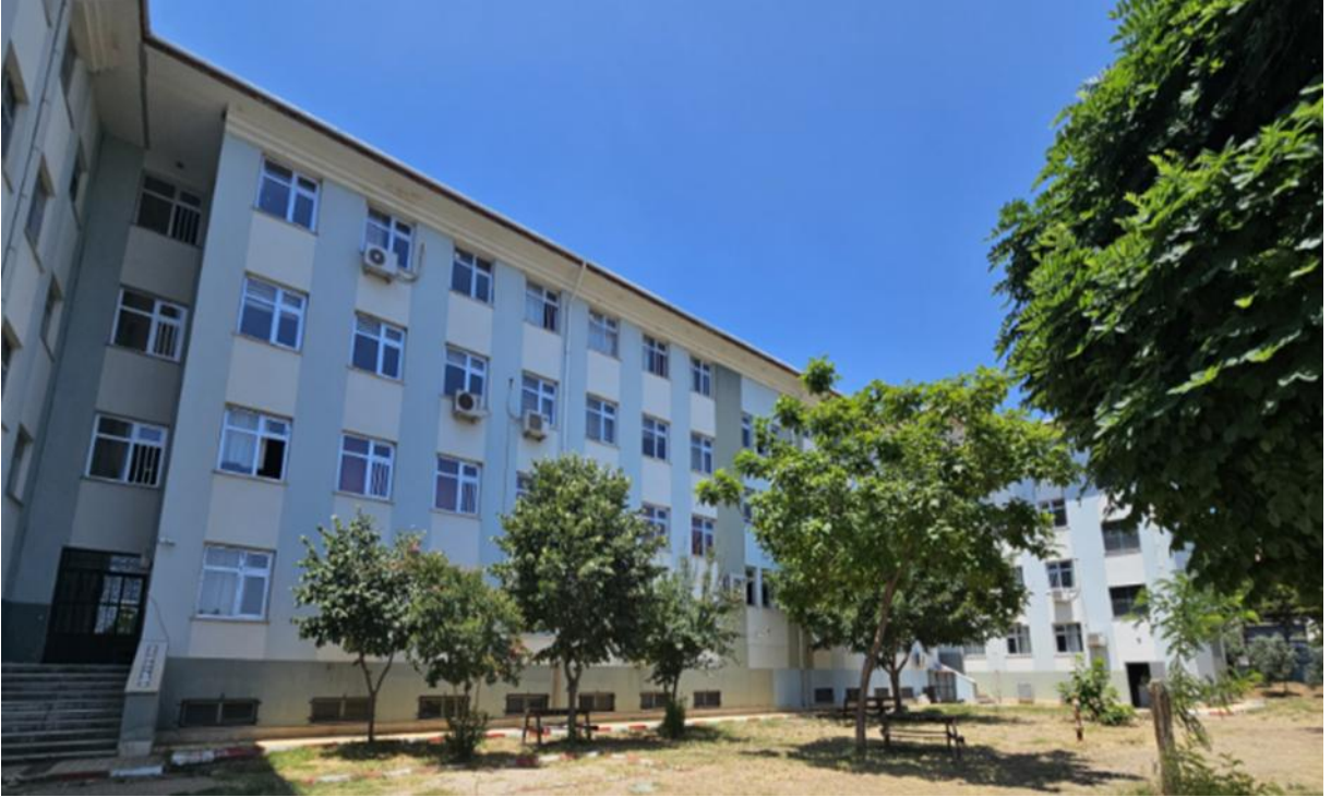
Fotoğraf 2: Nazilli Menderes Anadolu Lisesi Okul Binası Dış Cephe 2
