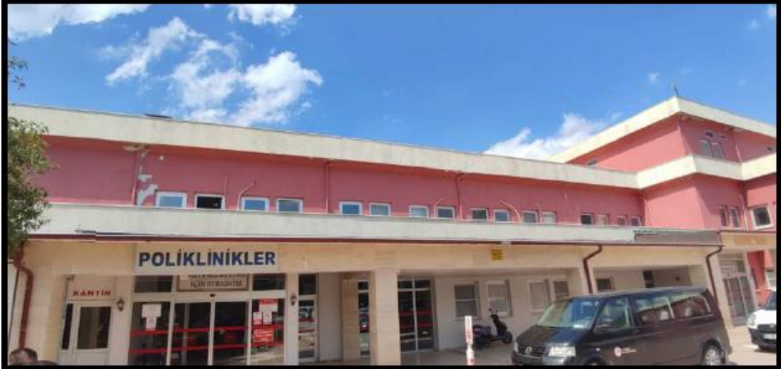
Fotoğraf 1: Konya Sarayönü Devlet Hastanesi Poliklinik Binası Girişi
