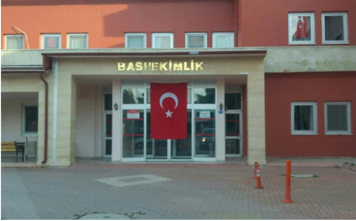
Fotoğraf 5: Konya Sarayönü Devlet Hastanesi Başhekimlik Binası Girişi
