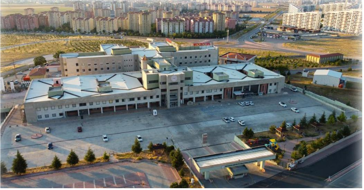
Fotoğraf 1: Konya Beyhekim Devlet Hastanesi A Blok Merkez Bina Görüntüsü
