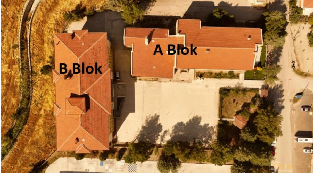
Şekil 2. Emekevler Mesleki ve Teknik Anadolu Lisesi Yerleşkesine Ait A ve B Blok Binalarının Üstten Görünüşü
