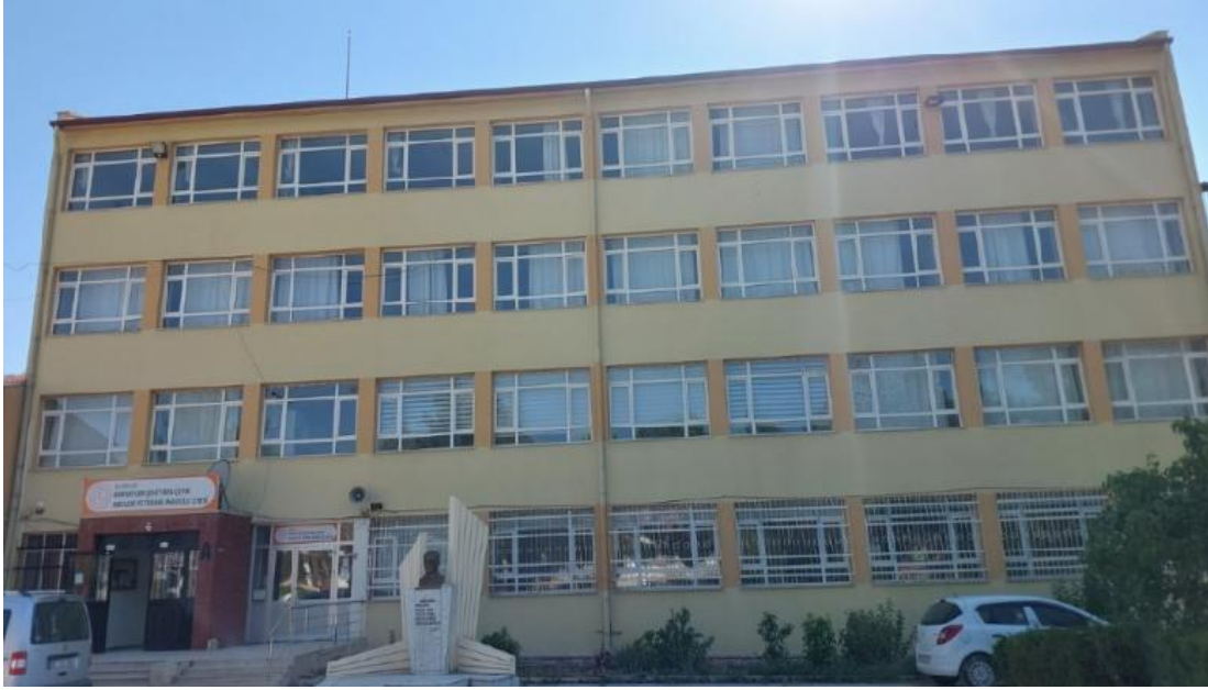
Şekil 5. Emekevlere Mesleki ve Teknik Anadolu Lisesi Bloklarında Kullanılan Pencere Sistemleri
