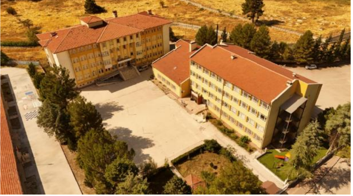
Şekil 8. Emekevler Mesleki ve Teknik Anadolu Lisesi Çatı Yapısı Genel Görşeli
