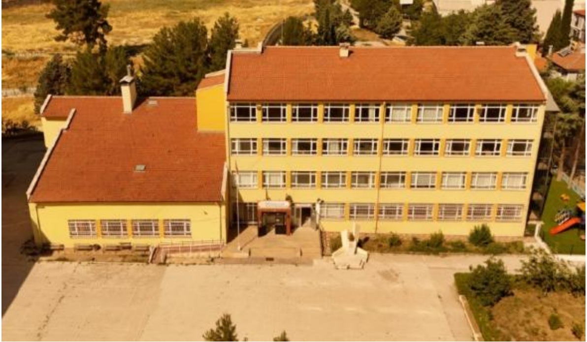
Şekil 3. Emekevler Mesleki ve Teknik Anadolu Lisesi A Blok Dış Cephe Görünüşü
