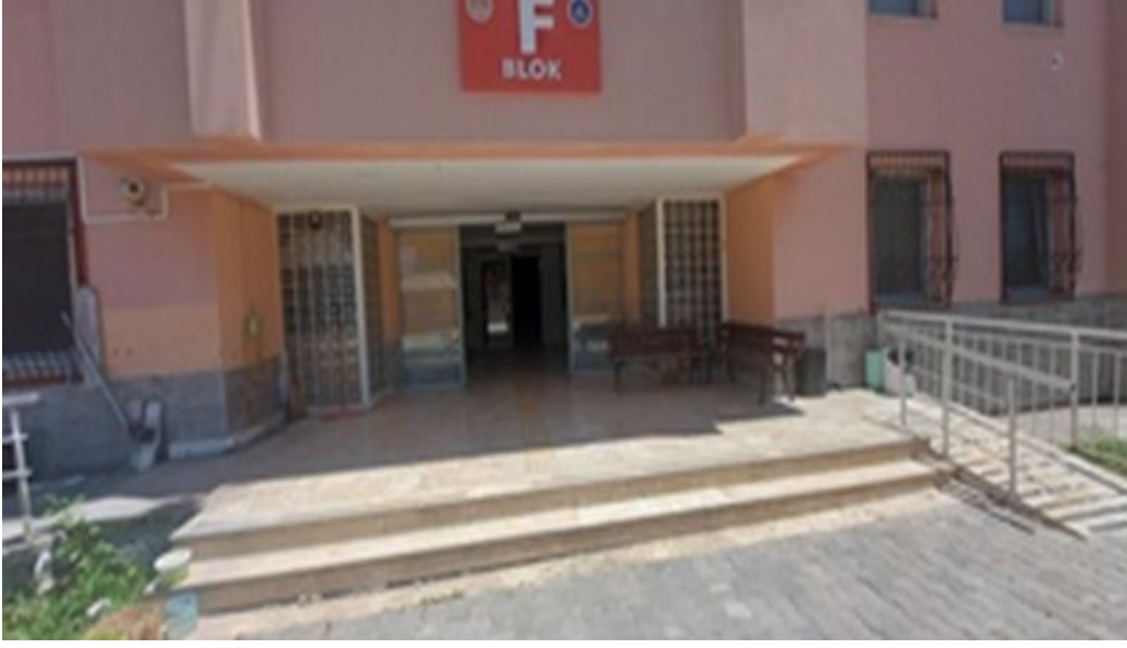
Şekil 5. Burdur Yurt Müdürlüğü E-F Blok Kapı Yapısı Görünümü
