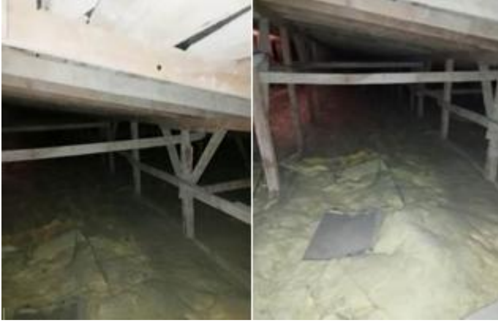
Şekil 6. Burdur Yurt Müdürlüğü E-F Blok Çatı Görünümü
