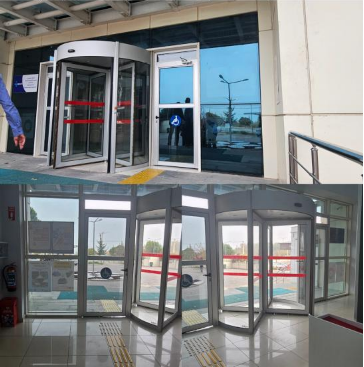
Şekil 5. Kapı Yapısı Örneği
