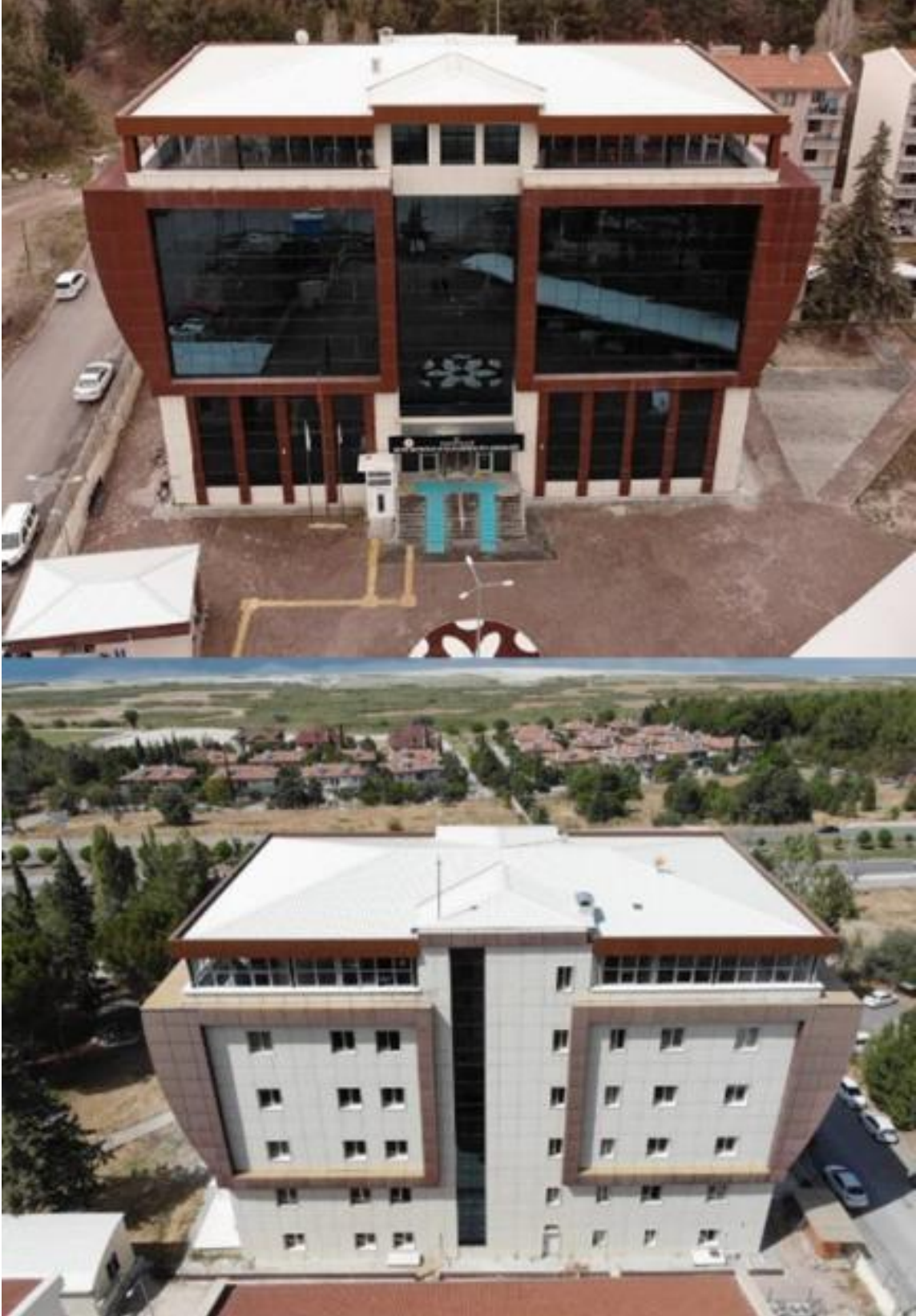
Şekil 3. Burdur Çevre ve Şehircilik İl Müdürlüğü
