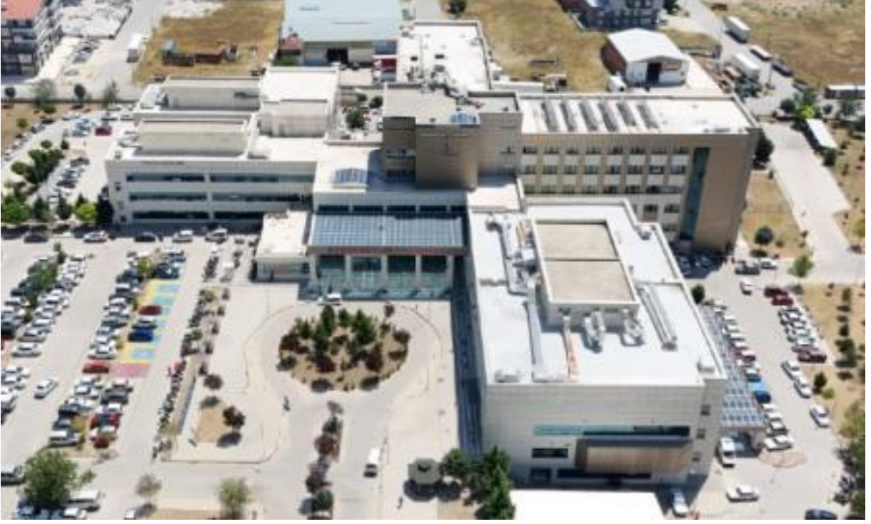
Şekil 6. Çatı Yapısı Genel Görşeli
