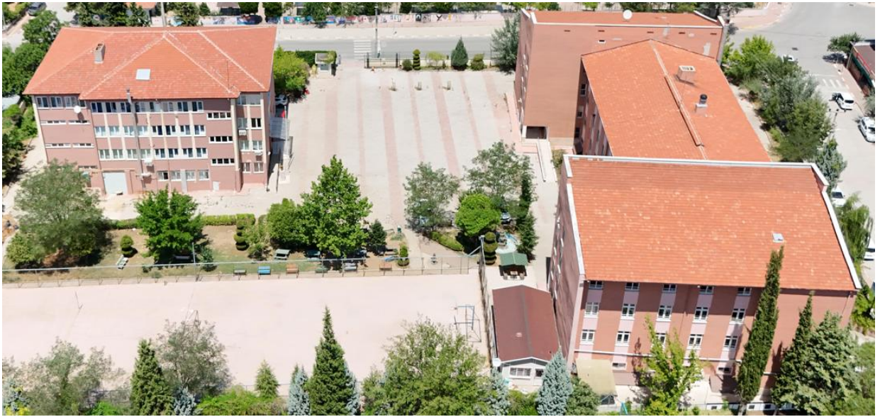
Şekil 8. Adem Tolunay Fen Lisesi Çatı Yapısı Genel Görşeli
