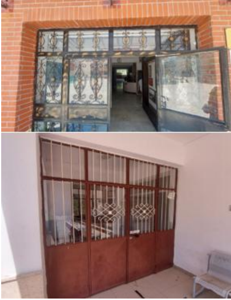
Şekil 7. Kapı-1 Yapısı Örneği
