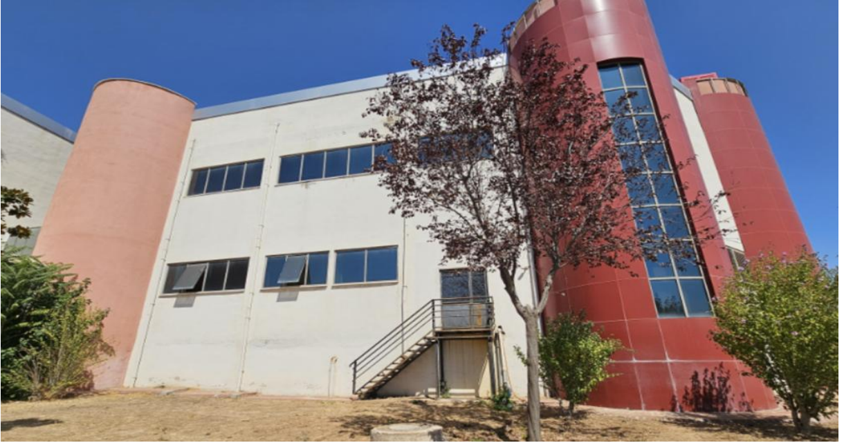
Fotoğraf 8: Kongre Merkezi Binası - Güney
