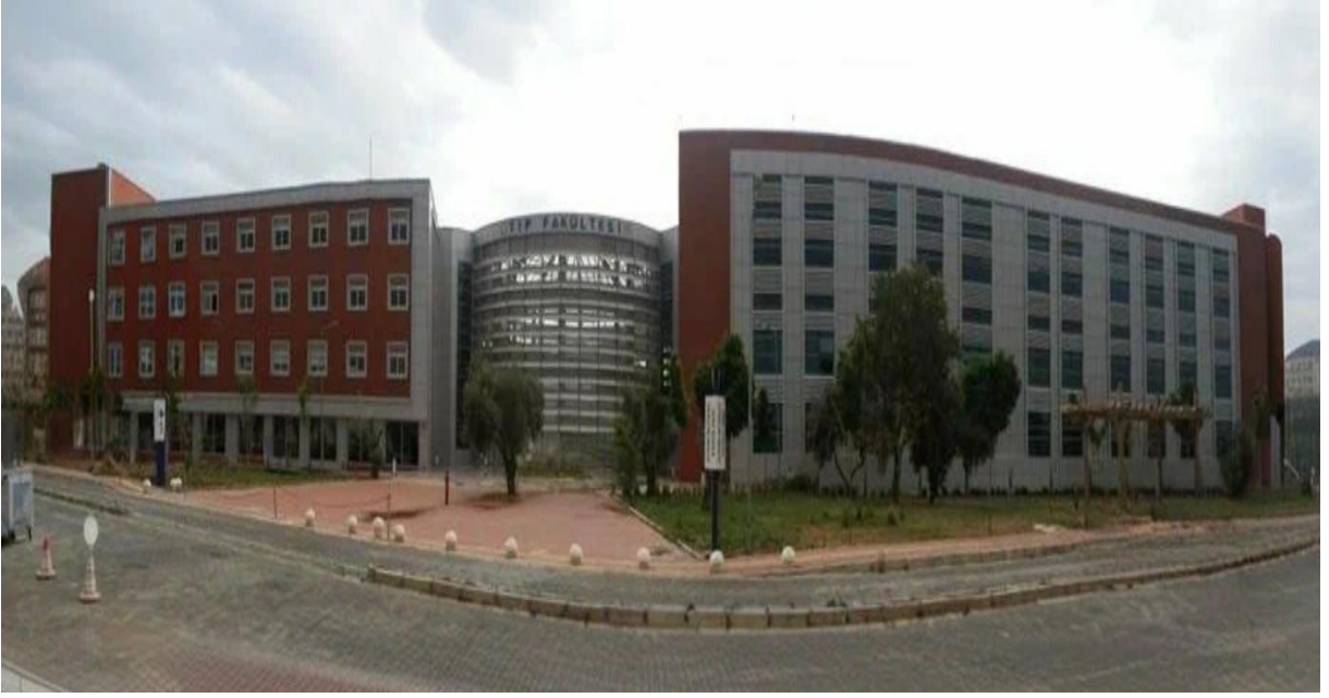
Fotoğraf 1: Tıp Fakültesi Derslik Binası - Doğu Dış Cephe
