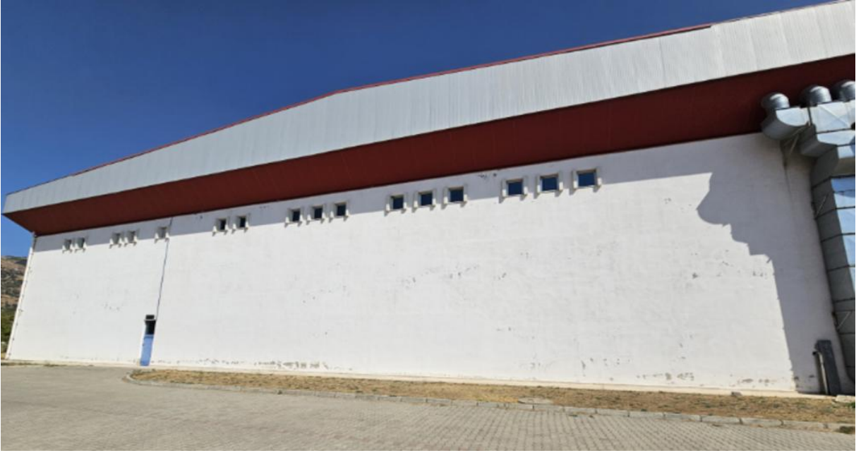
Fotoğraf 12: Kapalı Spor Salonu Binası - Batı
