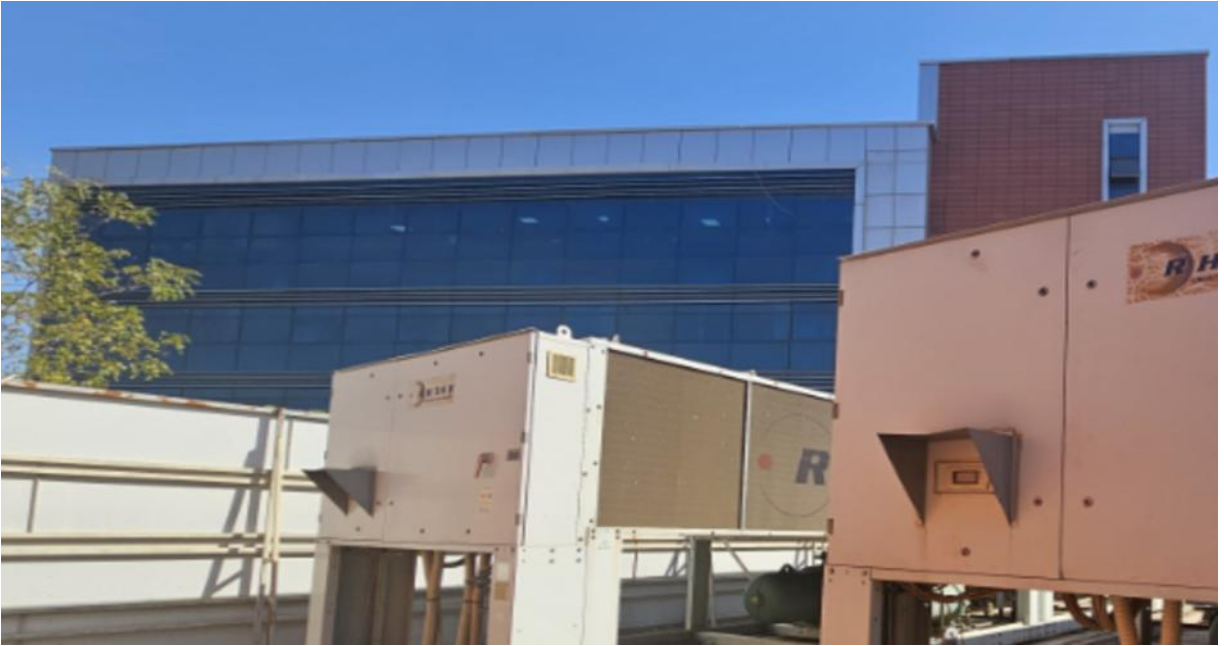
Fotoğraf 4: Tıp Fakültesi Derslik Binası - Kuzey Dış Cephe
