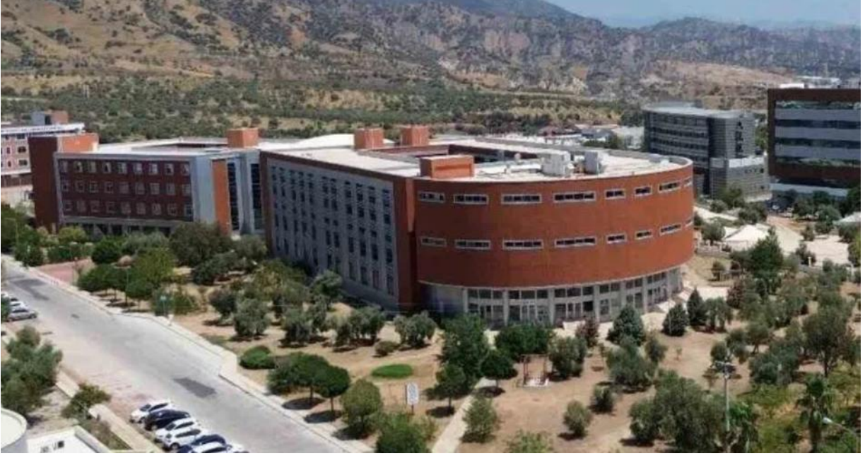
Fotoğraf 3: Tıp Fakültesi Derslik Binası - Güney Dış Cephe
