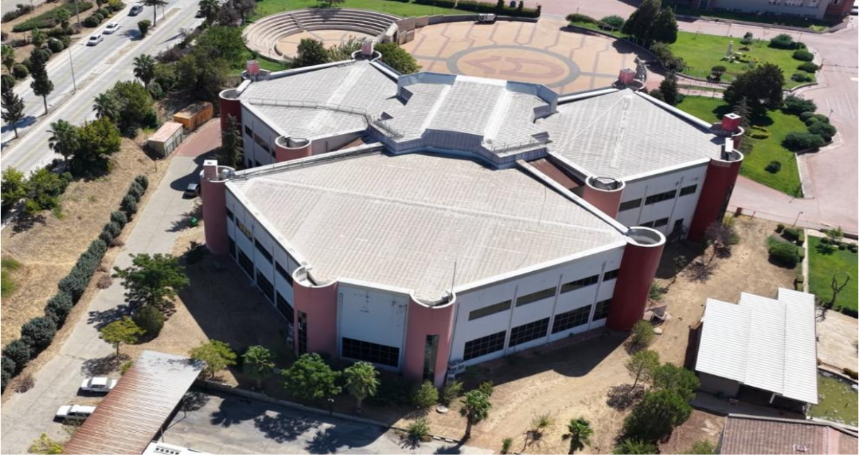
Fotoğraf 18: Kongre Binası Çatısı
