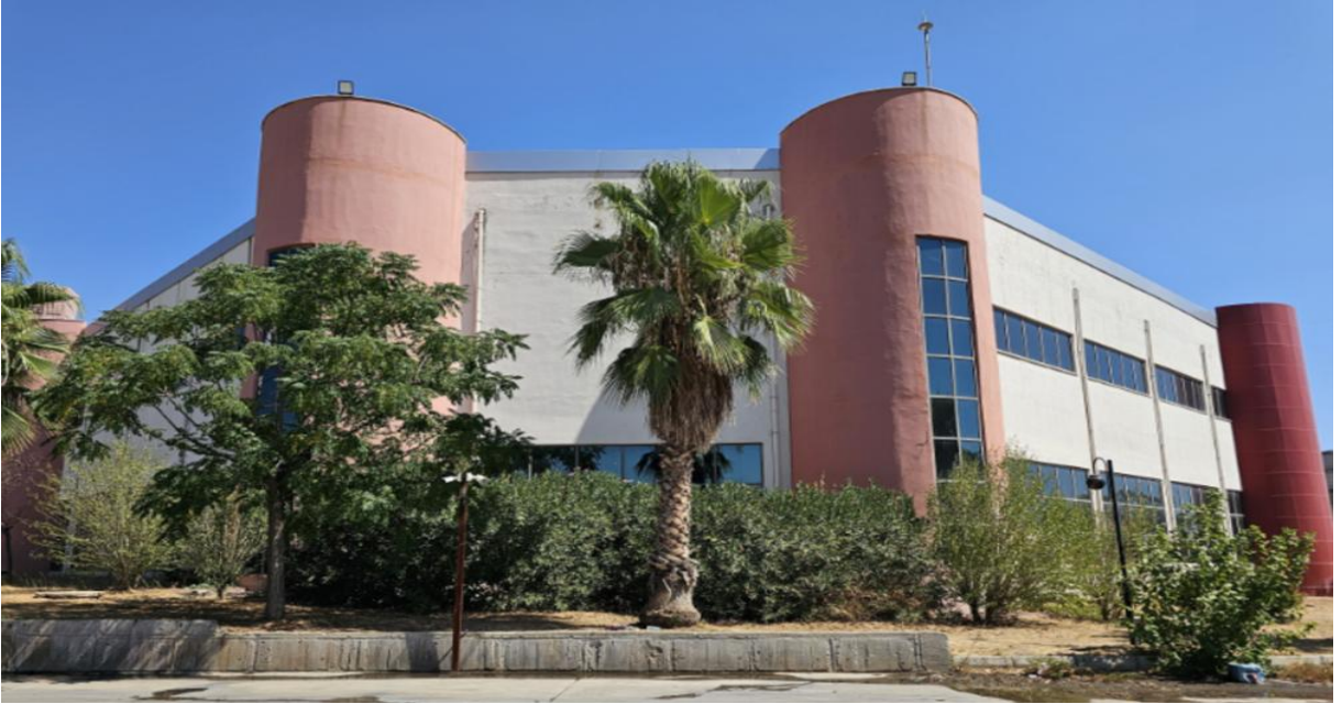
Fotoğraf 6: Kongre Merkezi Binası - Batı
