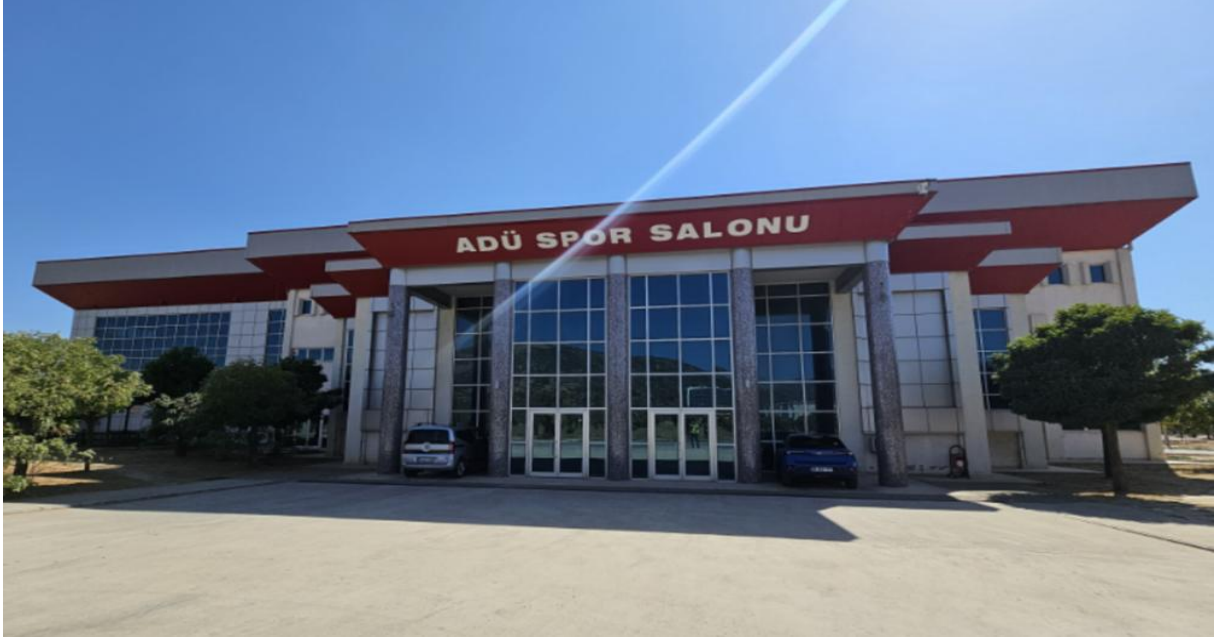
Fotoğraf 9: Kapalı Spor Salonu Binası - Kuzey
