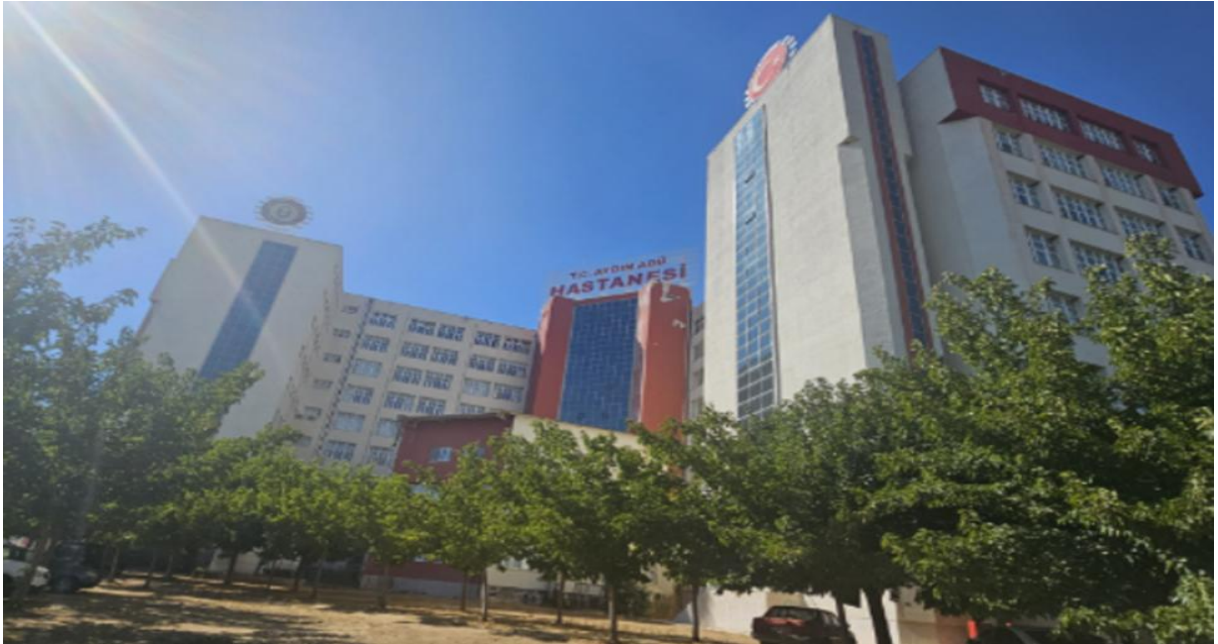
Fotoğraf 16: Hastane Binası - Batı
