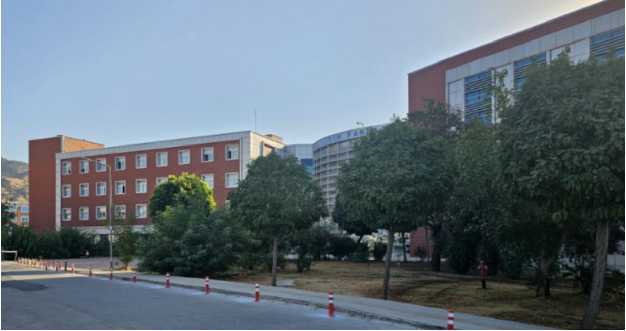
Fotoğraf 2: Tıp Fakültesi Derslik Binası - Batı Dış Cephe
