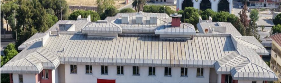
Fotoğraf 6: Nazilli Adliyesi Binasi Çatı 1
