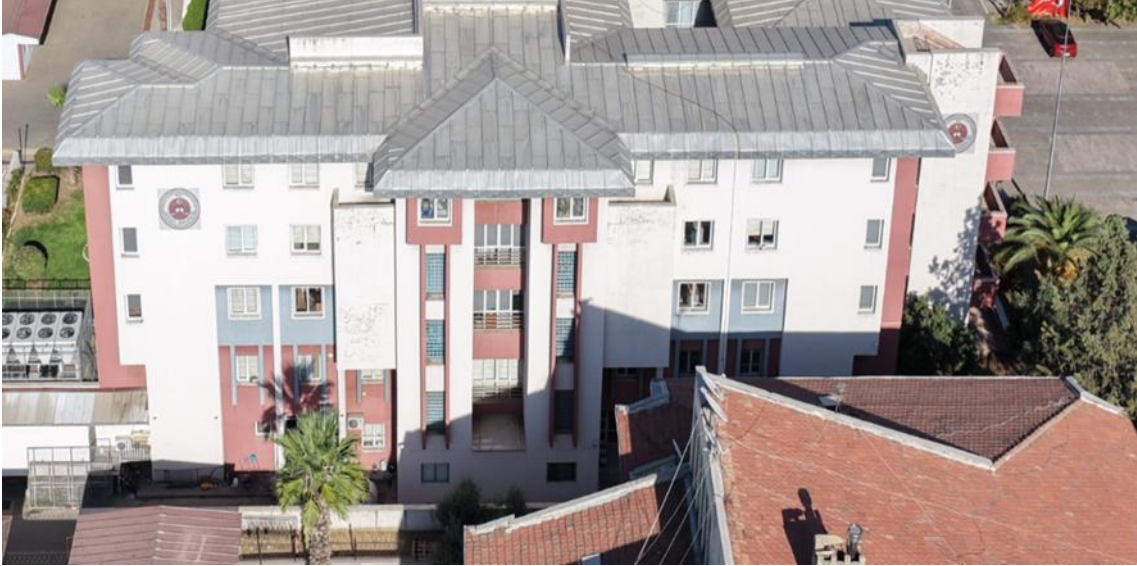
Fotoğraf 4: Nazilli Adliyesi Binası Dış Cephe 3
