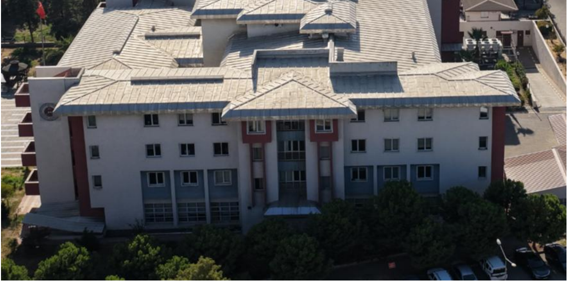
Fotoğraf 5: Nazilli Adliyesi Binasi Dış Cephe 4
