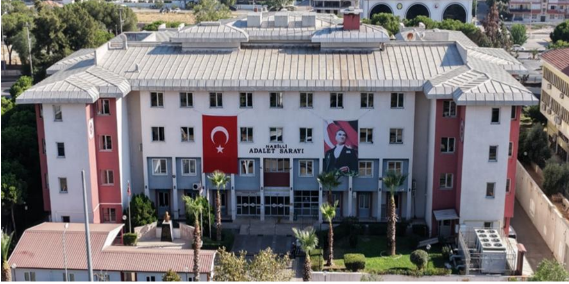
Fotoğraf 3: Nazilli Adliyesi Binası Dış Cephe 2
