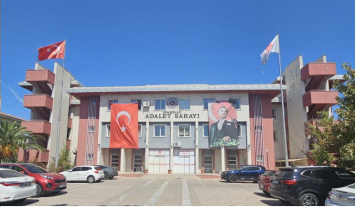
Fotoğraf 2: Nazilli Adliyesi Binası Dış Cephe 1
