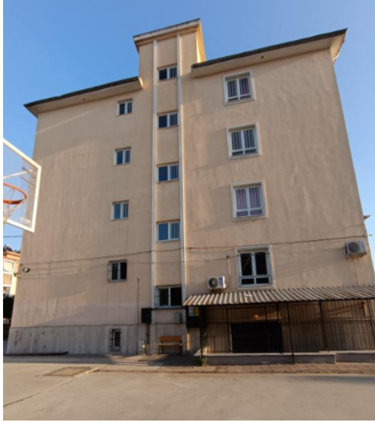
Fotoğraf 4: Murat Hale Küçüköğlü MTAL Hatip Lisesi Okul Binası Dış Cephe 4
