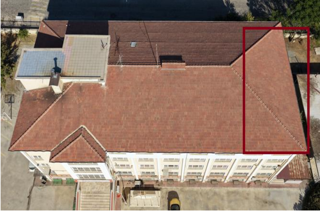
Fotoğraf 5: Murat Hale Küçükoğlu MTAL Okul Binası Çatı 1
