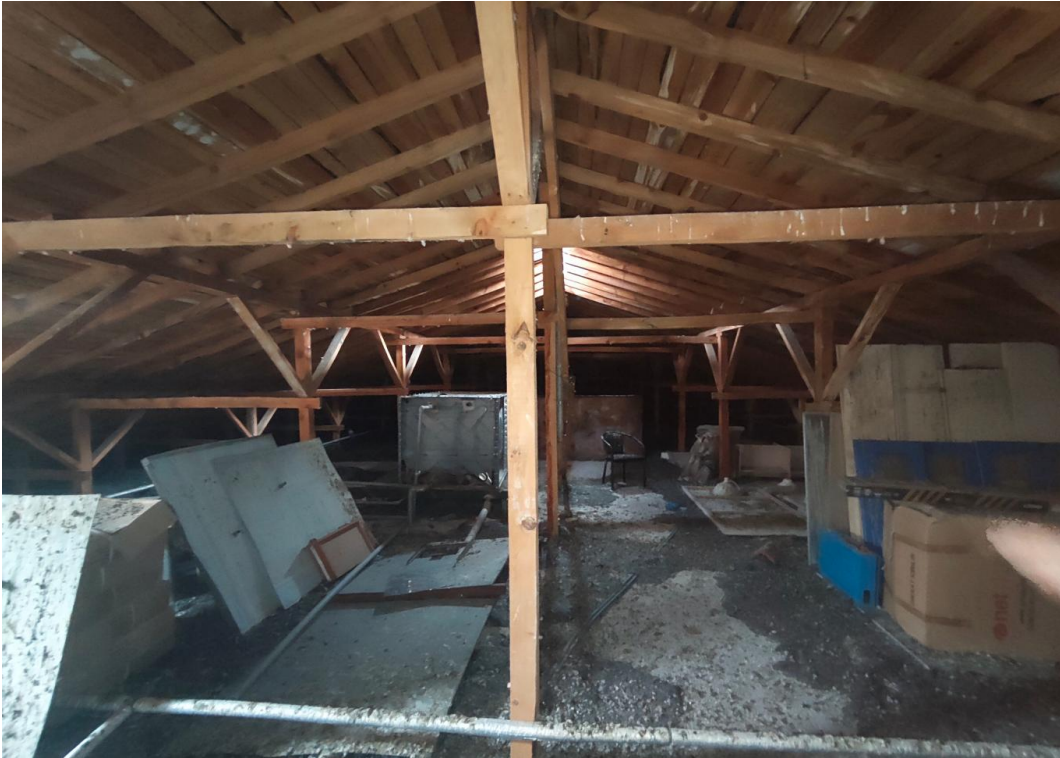
Fotoğraf 6: Murat Hale Küçükoğlu MTAL Okul Binası Çatı 2
