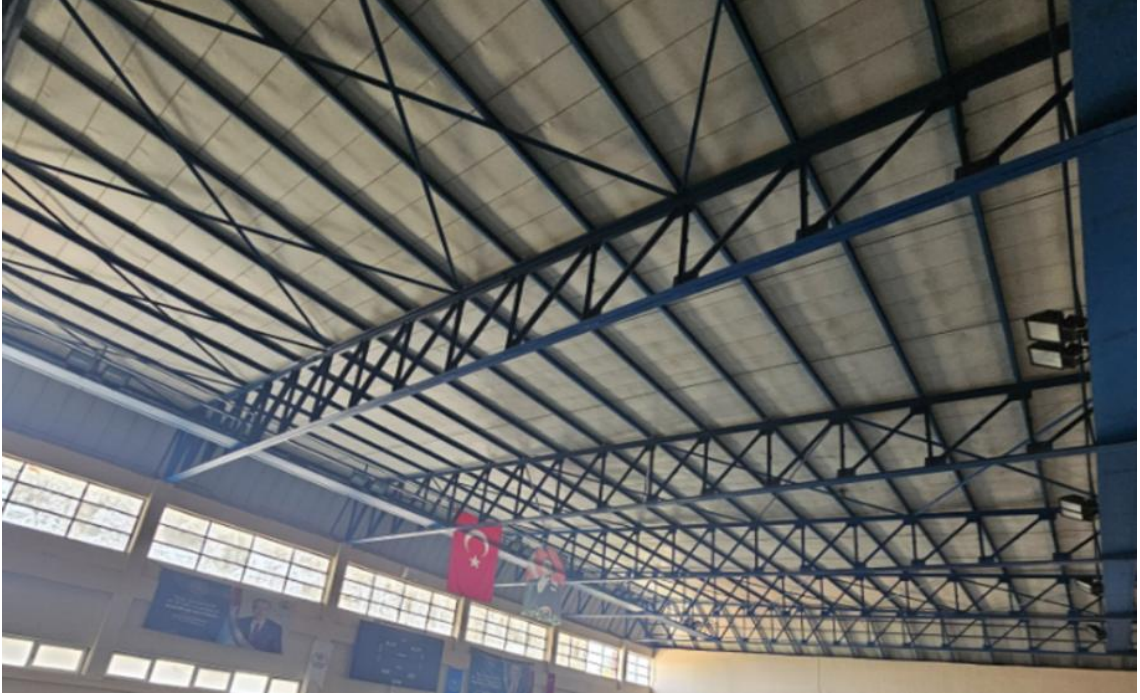
Fotoğraf 7: İncirliova Gençlik ve Spor Bölge Müdürlüğü Binası Çatı 2
