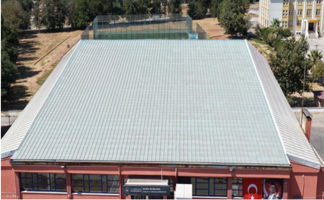
Fotoğraf 6: İncirliova Gençlik ve Spor Bölge Müdürlüğü Binası Çatı 1
