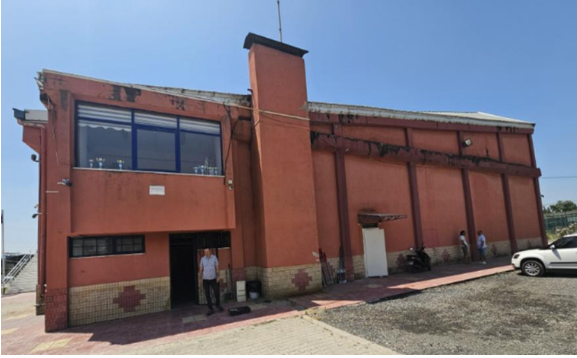
Fotoğraf 5: İncirliova Gençlik ve Spor Bölge Müdürlüğü Binası Dış Cephe 4
