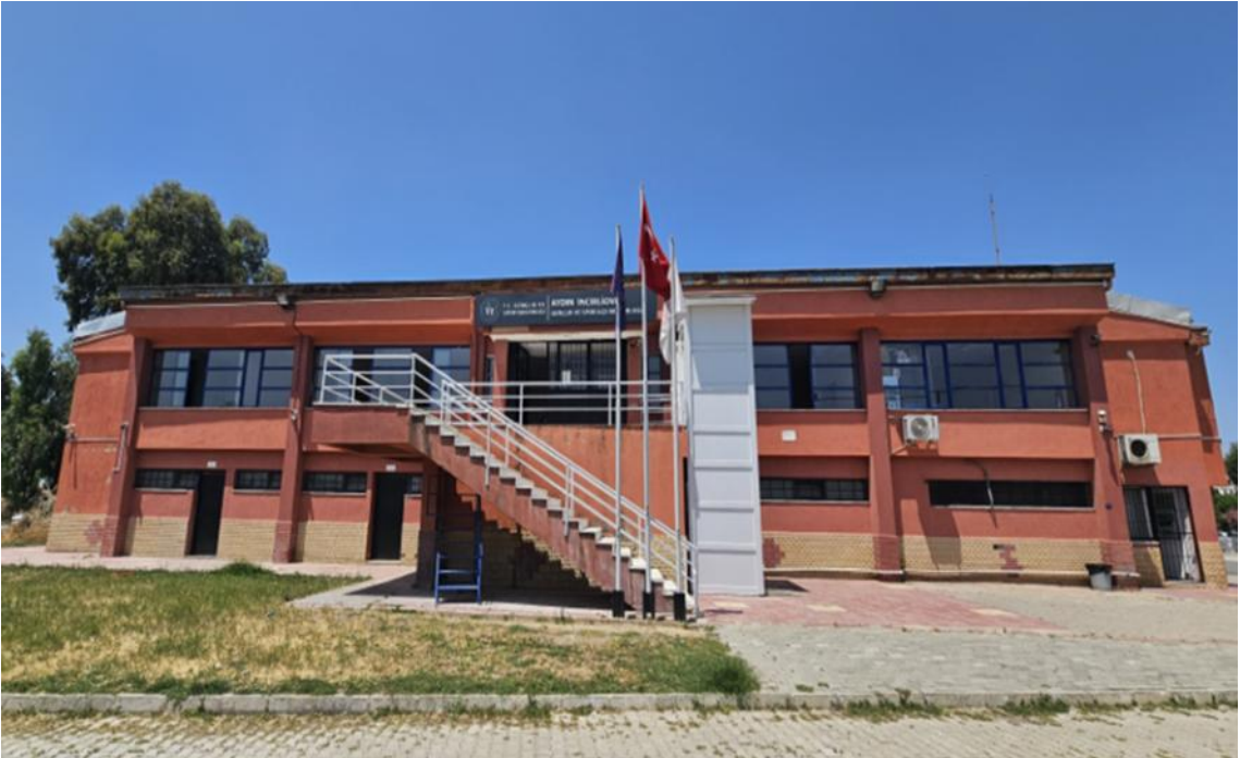
Fotoğraf 2: İncirliova Gençlik ve Spor Bölge Müdürlüğü Binası Dış Cephe 1
