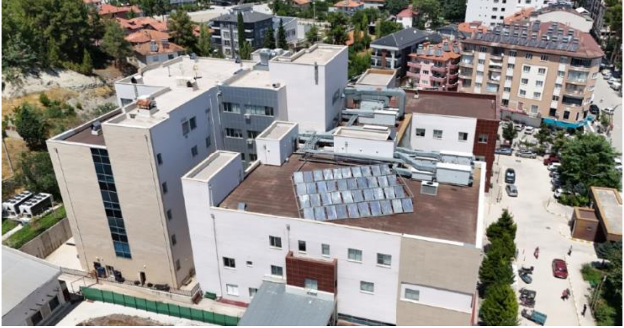
Şekil 6. Çatı Yapısı Genel Görşeli
