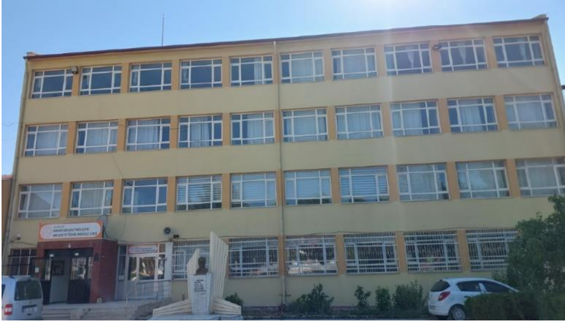
Şekil 5. Emekevler Mesleki ve Teknik Anadolu Lisesi Bloklarında Kullanılan Pencere Sistemleri
