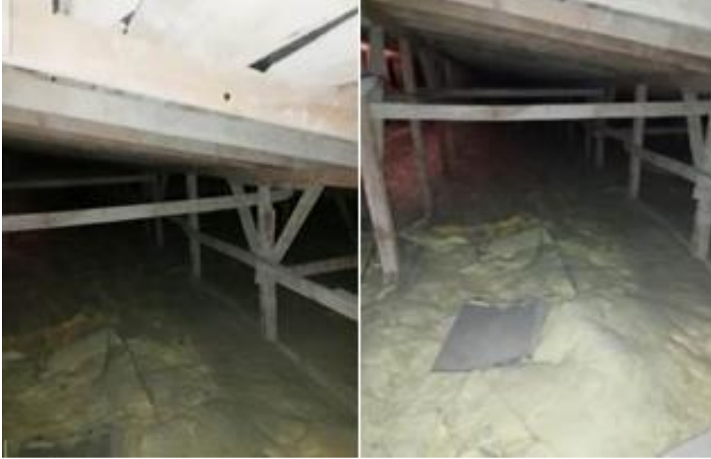
Şekil 6. Burdur Yurt Müdürlüğü E-F Blok Çatı Görünümü
