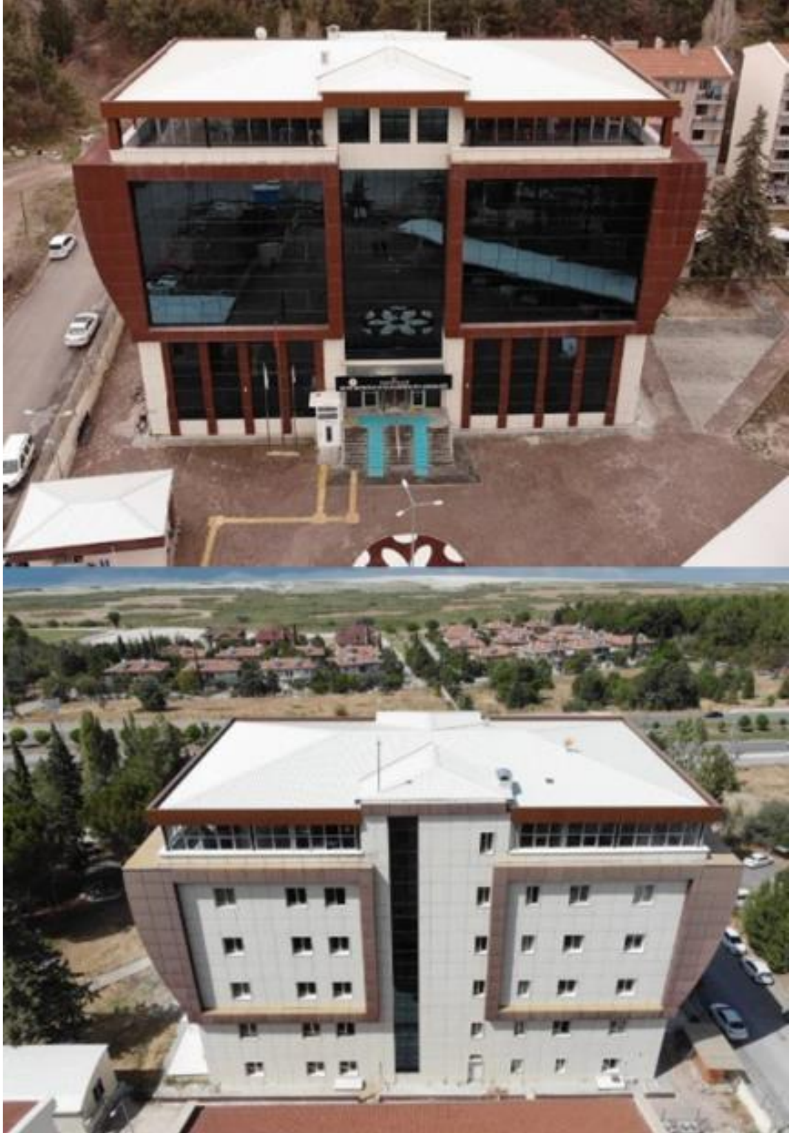
Şekil 3. Burdur Çevre ve Şehircilik İl Müdürlüğü
