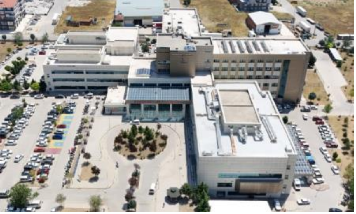
Şekil 6. Çatı Yapısı Genel Görşeli
