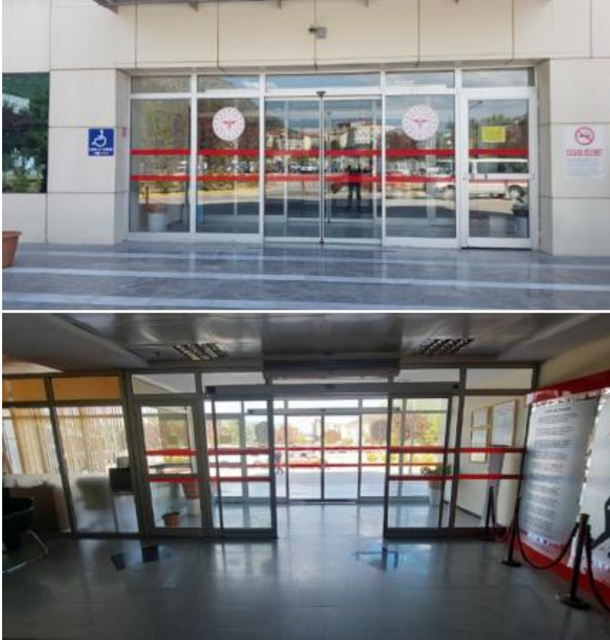
Şekil 5. Yerleşke Kapı-1 Yapısı Örneği
