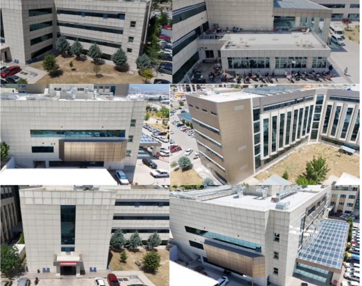
Şekil 3. Bucak Devlet Hastanesi Duvar Görünümü
