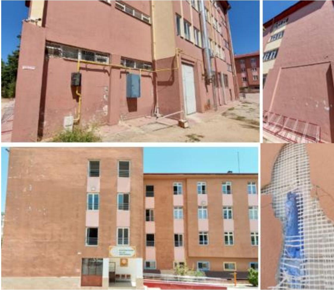
Şekil 5. Adem Tolunay Fen Lisesi Duvar Katmanları
