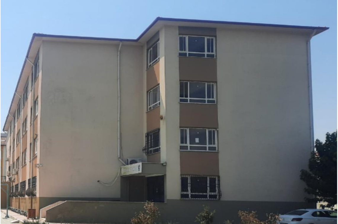
Fotoğraf 4: Aydın İncirliova Spor Lisesi Okul Binası Dış Cephe 3
