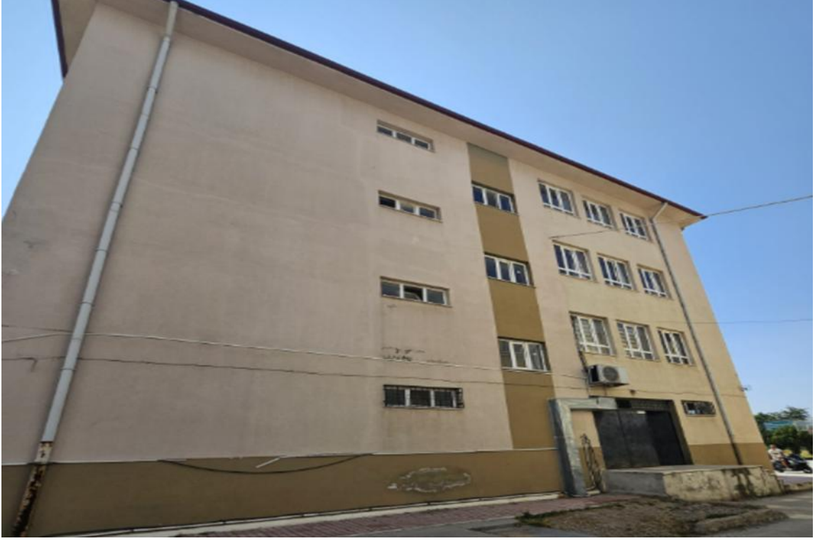
Fotoğraf 5: Aydın İncirliova Spor Lisesi Okul Binası Dış Cephe 4
