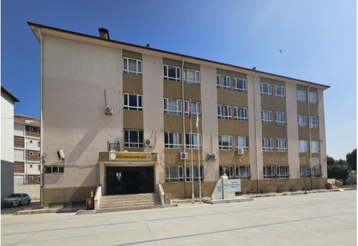
Fotoğraf 2: Aydın İncirliova Spor Lisesi Okul Binası Dış Cephe 1
