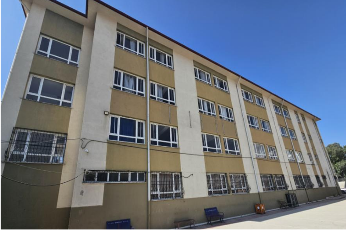
Fotoğraf 3: Aydın İncirliova Spor Lisesi Okul Binası Dış Cephe 2
