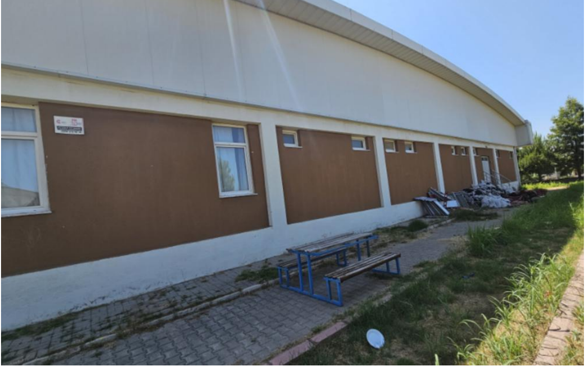
Fotoğraf 15: Nazilli Asımın Nesli Anadolu İmam Hatip Lisesi Spor Salonu Binası Dış Cephe 4
