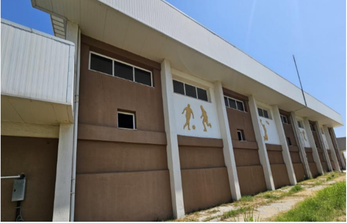
Fotoğraf 13: Nazilli Asımın Nesli Anadolu İmam Hatip Lisesi Spor Salonu Binası Dış Cephe 2
