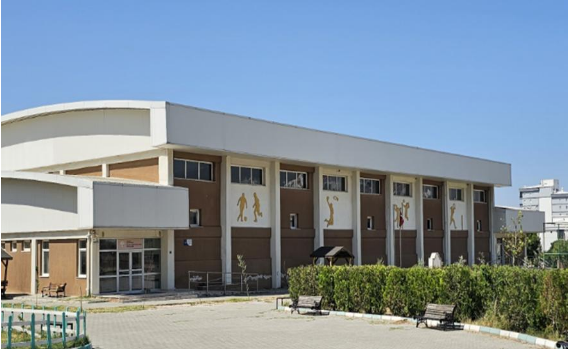
Fotoğraf 12: Nazilli Asımın Nesli Anadolu İmam Hatip Lisesi Spor Salonu Binası Dış Cephe 1
