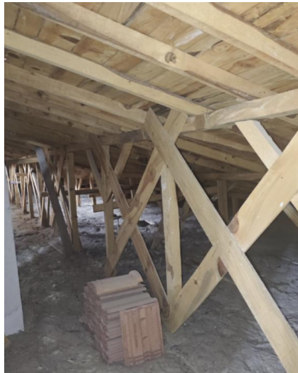
Fotoğraf 9: Çine Anadolu İmam Hatip Lisesi Okul Binası Çatı 3
