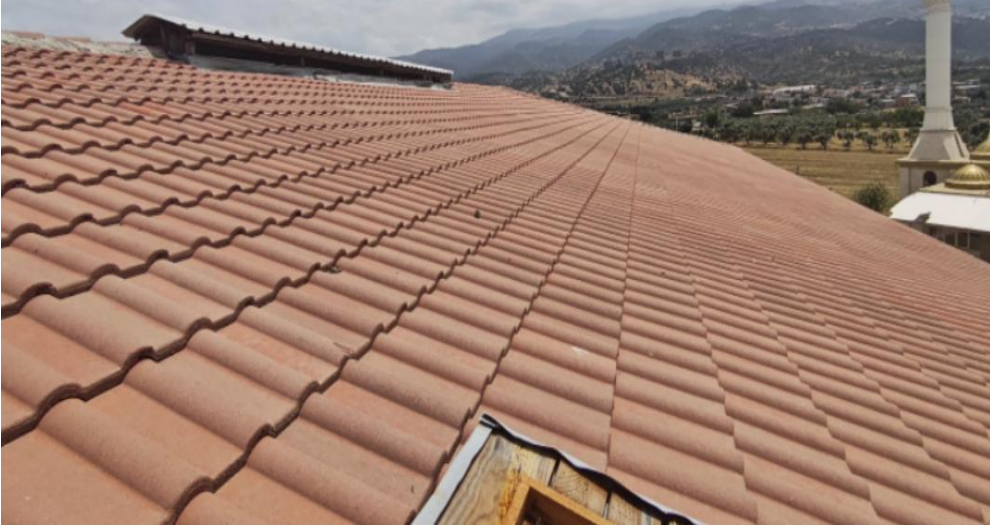
Fotoğraf 7: Çine Anadolu İmam Hatip Lisesi Okul Binası Çatı 1
