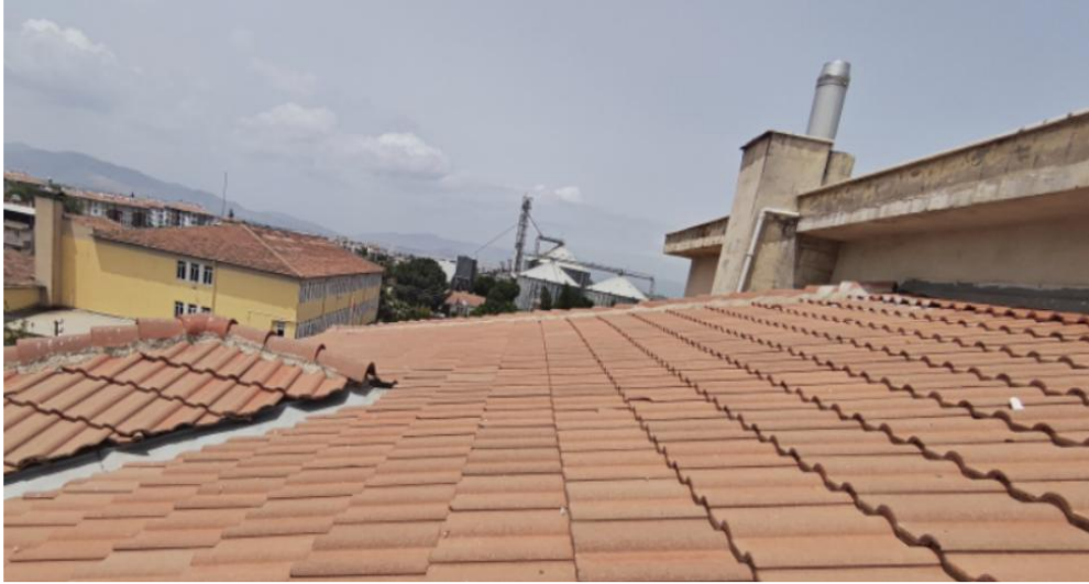
Fotoğraf 8: Çine Anadolu İmam Hatip Lisesi Okul Binası Çatı 2
