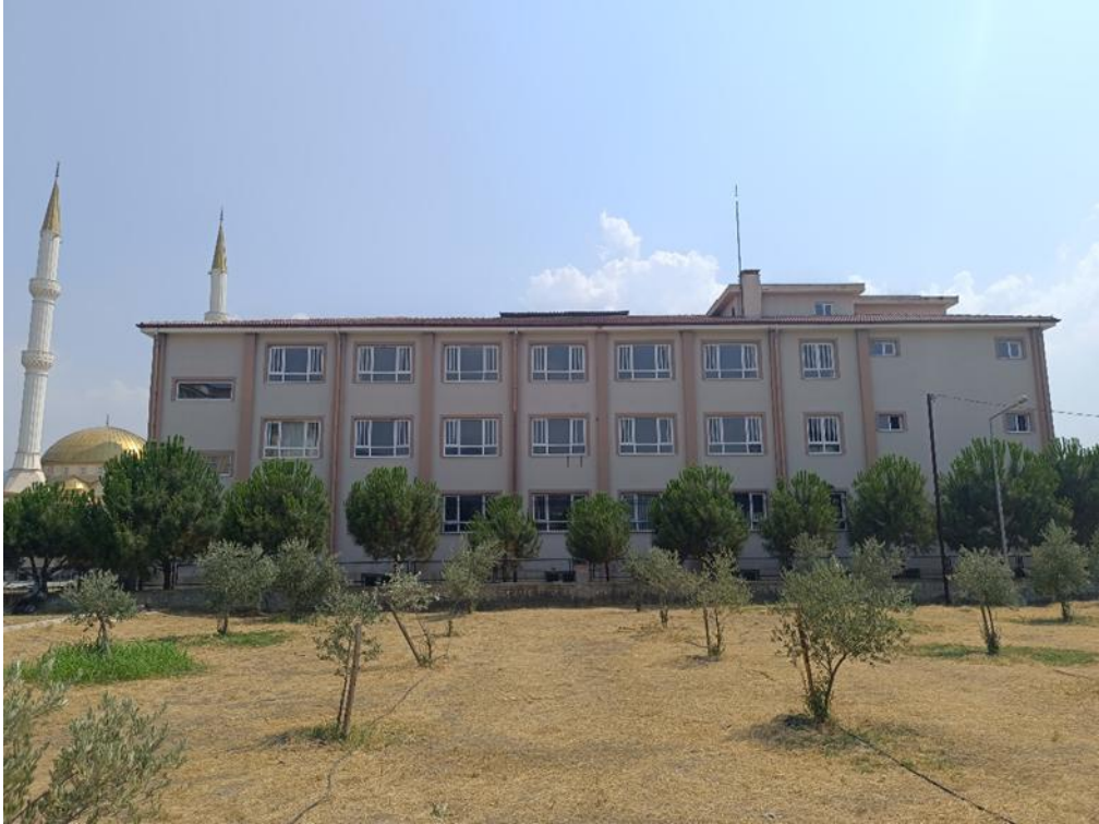
Fotoğraf 4: Çine Anadolu İmam Hatip Lisesi Okul Binası Dış Cephe 4
