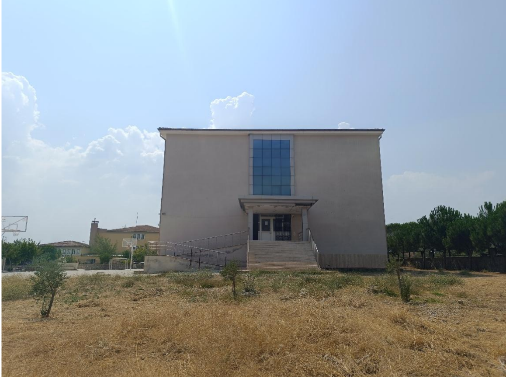
Fotoğraf 3: Çine Anadolu İmam Hatip Lisesi Okul Binası Dış Cephe 3
