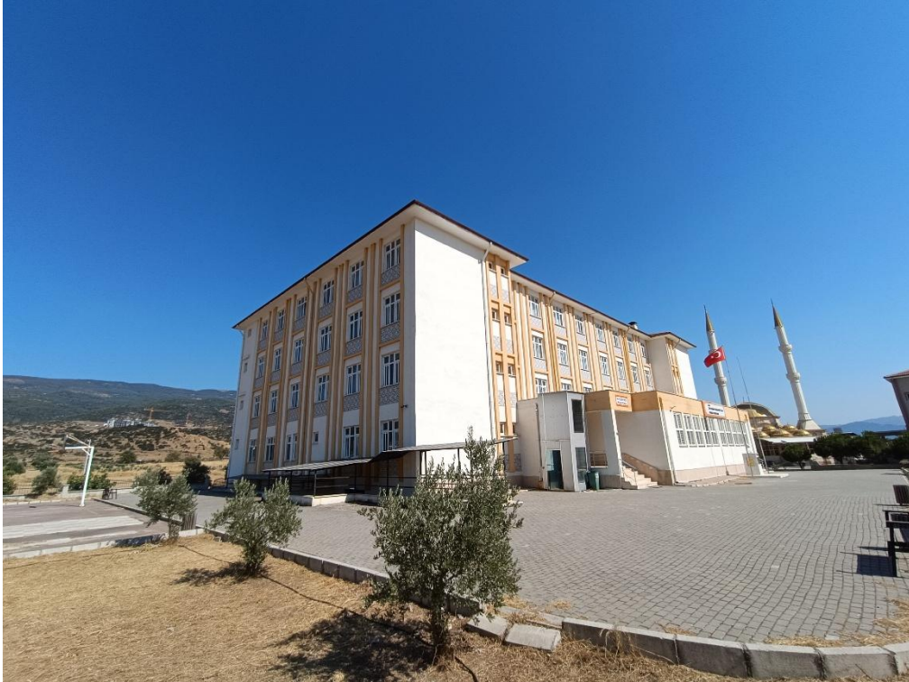
Fotoğraf 11: Çine Anadolu İmam Hatip Lisesi Yurt Binası Dış Cephe 2
