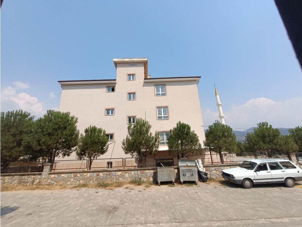
Fotoğraf 6: Çine Anadolu İmam Hatip Lisesi Okul Binası Dış Cephe 6
