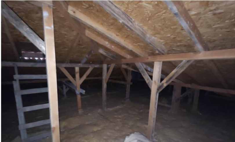
Fotoğraf 18: Çine Anadolu İmam Hatip Lisesi Yurt Binası Çatı 2
