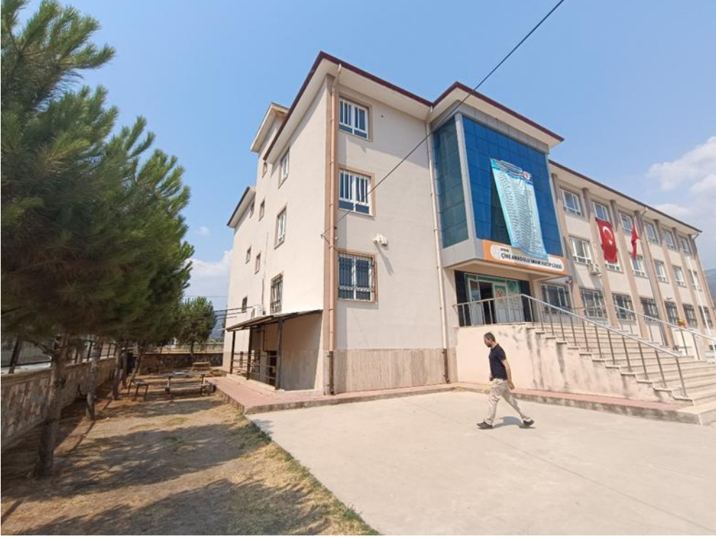
Fotoğraf 5: Çine Anadolu İmam Hatip Lisesi Okul Binası Dış Cephe 5
