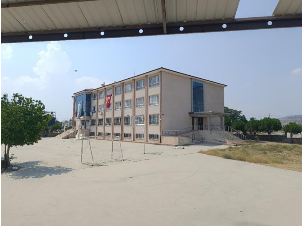
Fotoğraf 2: Çine Anadolu İmam Hatip Lisesi Okul Binası Dış Cephe 2
