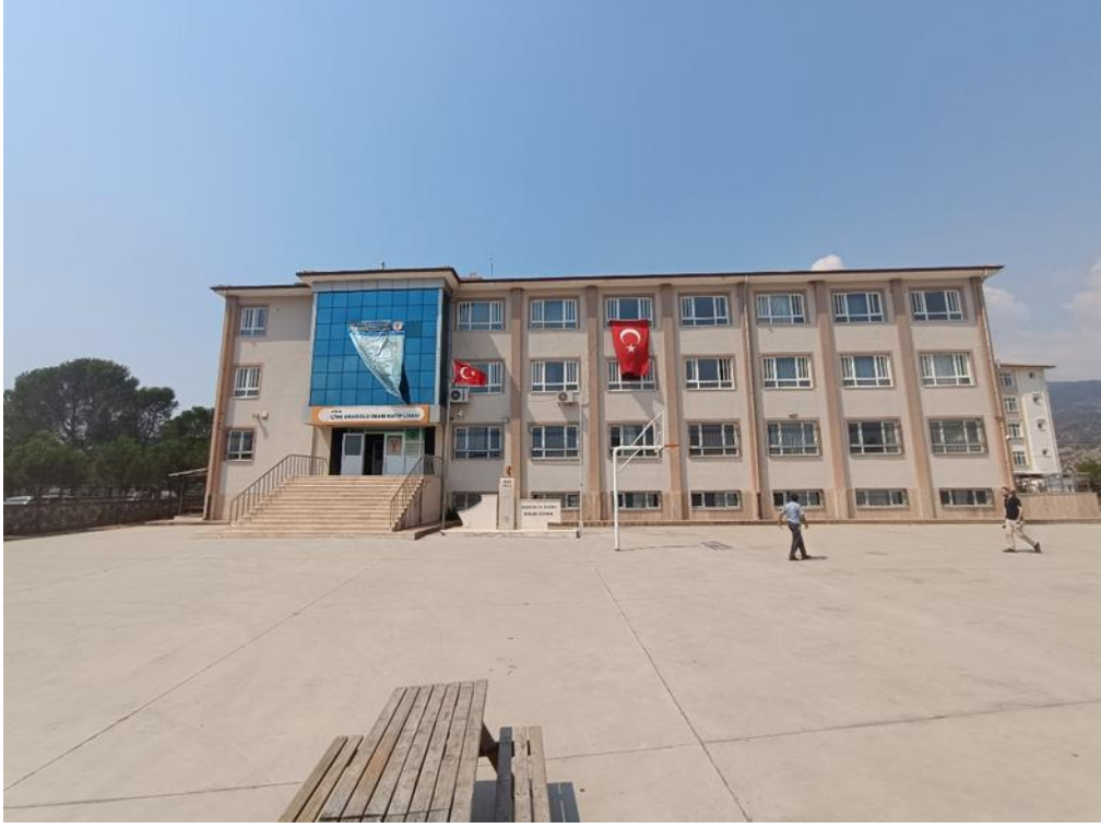
Fotoğraf 1: Çine Anadolu İmam Hatip Lisesi Okul Binası Dış Cephe 1
