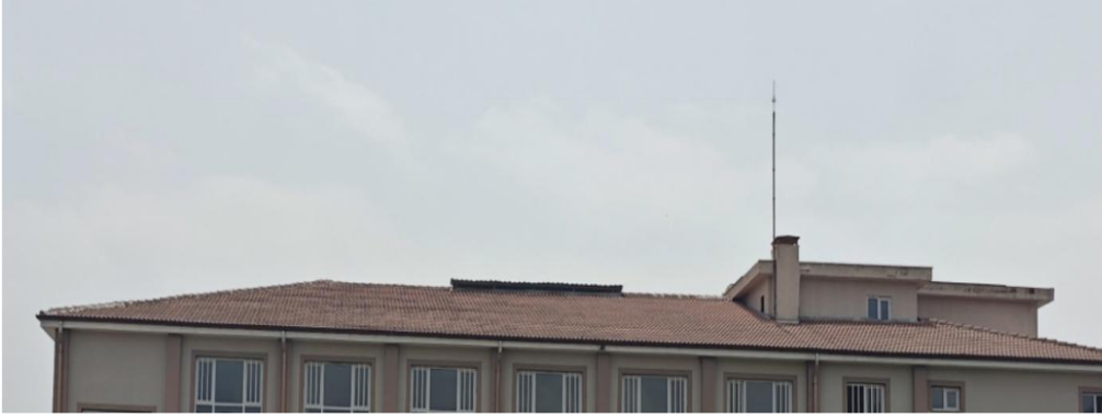
Fotoğraf 17: Çine Anadolu İmam Hatip Lisesi Yurt Binası Çatı 1
