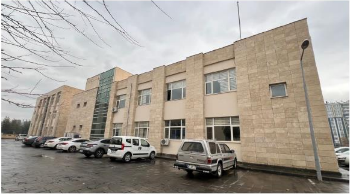
Fotoğraf 4: Diyarbakır Gümrük Müdürlüğü Tasfiye İşletme Binası Dışarıdan Görünümü
