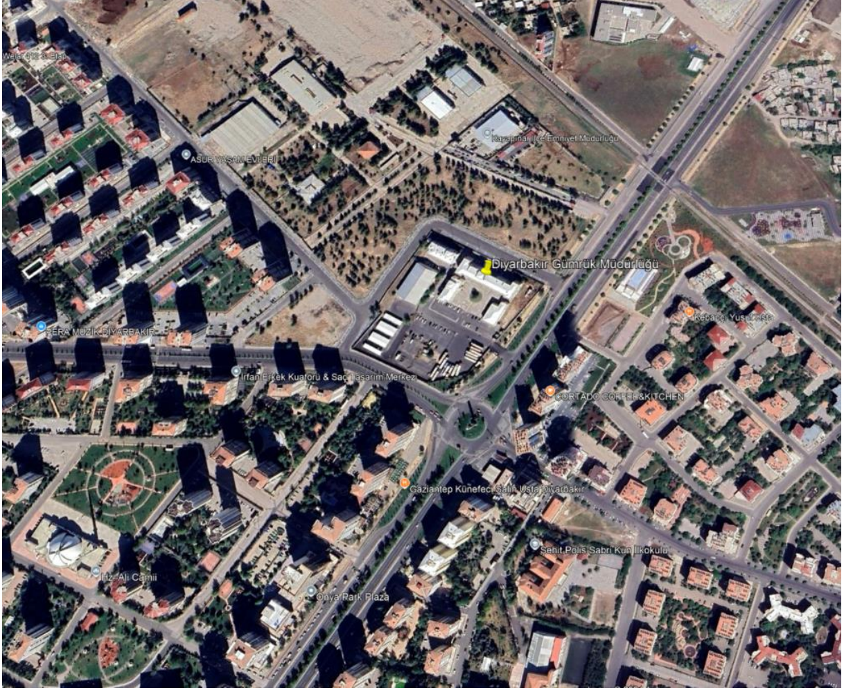
Şekil 3: Diyarbakır Gümrük Müdürlüğü Uydu Görüntüsü-2
