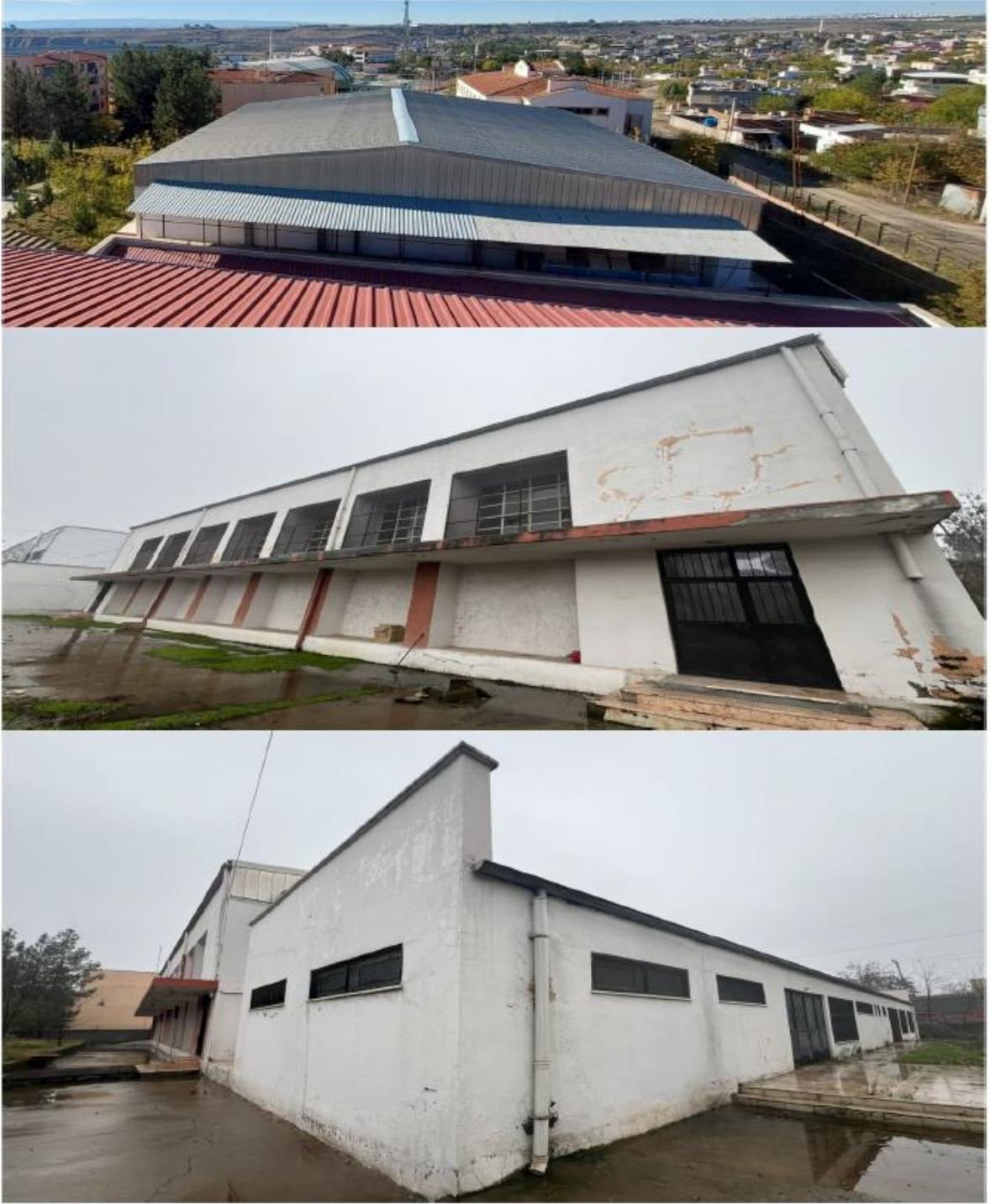
Fotoğraf 4: Vali Aydın Arslan Fen Lisesi Spor Salonu Binası Dışarıdan Görünümü
