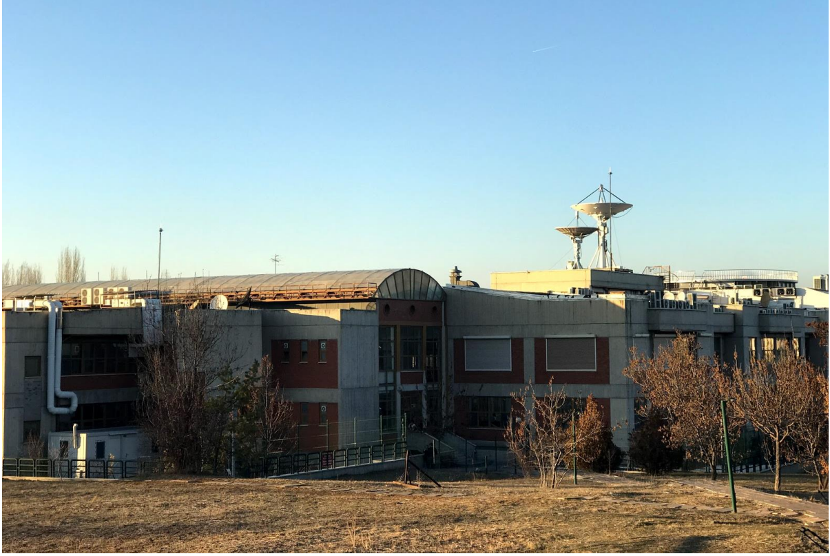
Şekil 3. TÜBİTAK Uzay Teknolojileri Araştırma Enstitüsü Dış Görünüş-3
