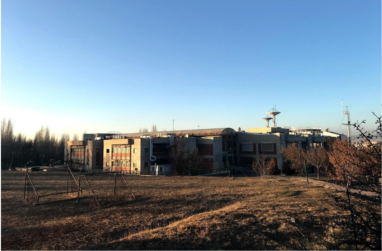
Şekil 2. TÜBİTAK Uzay Teknolojileri Araştırma Enstitüsü Dış Görünüş-2
