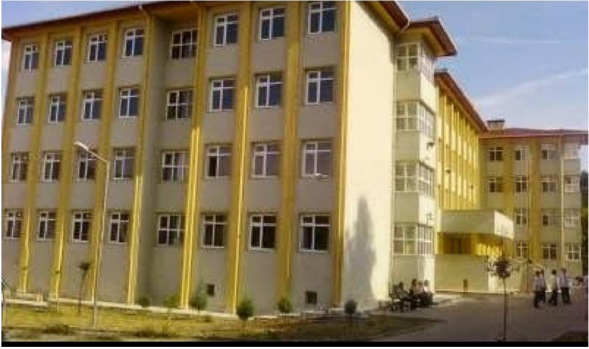
Şekil 1. Şehit Ridvan Süer Anadolu Lisesi Dış Görünüş
