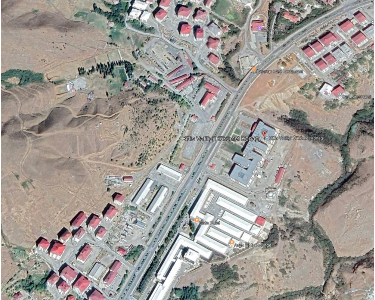
Şekil 2: Bitlis Hükümet Binası Uydu Görüntüsü-2
