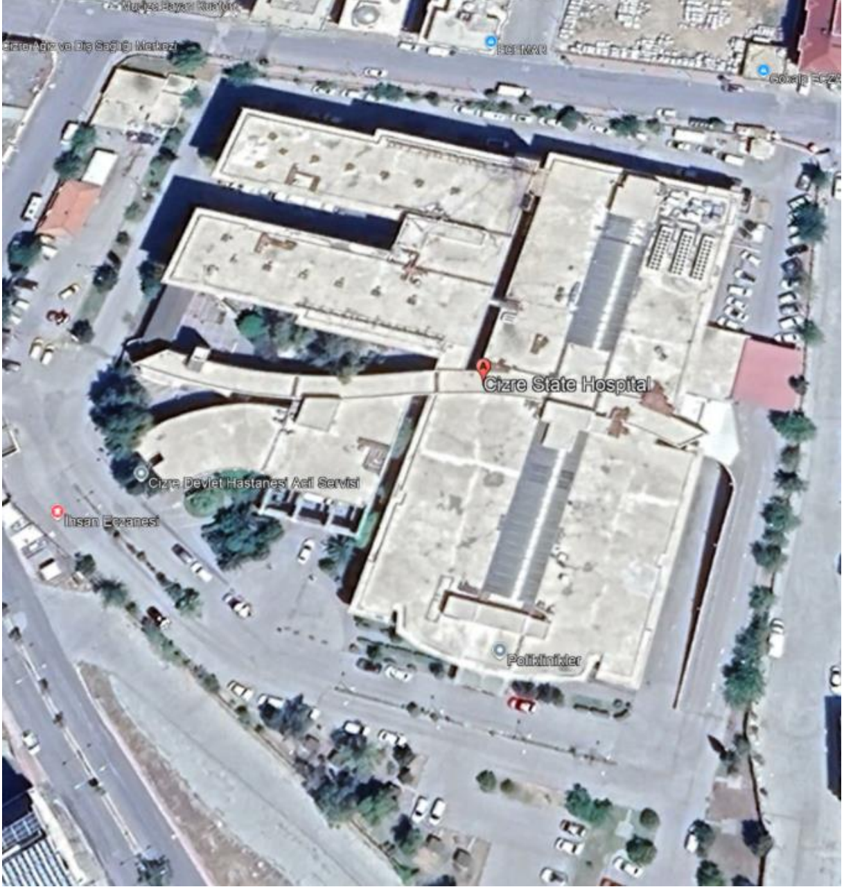
Şekil 4: Cizre Devlet Hastanesi Yerleşkesi Üsten Görünümü
