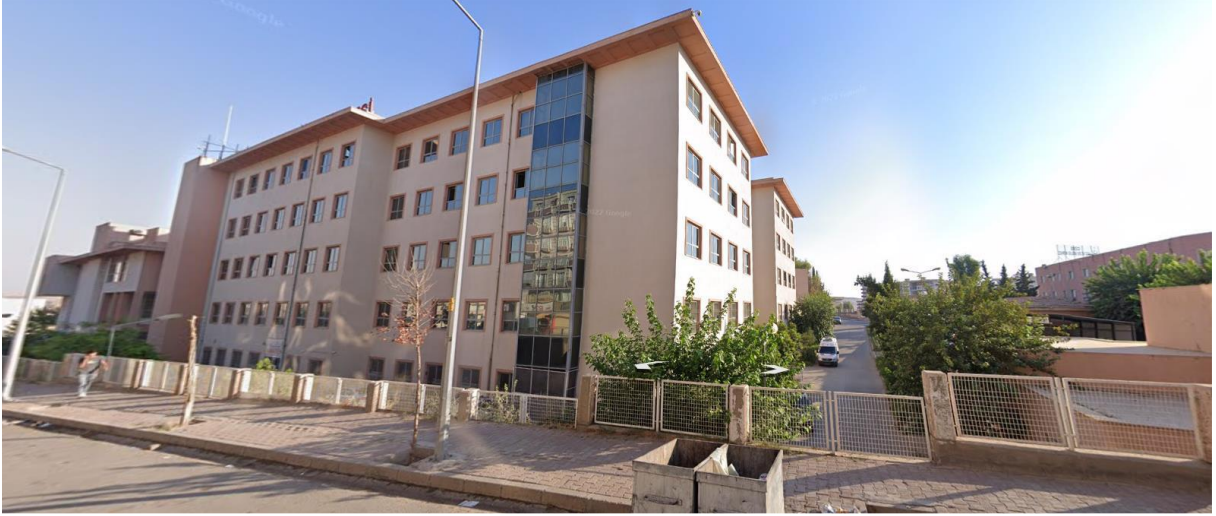
Fotoğraf 2: Cizre Devlet Hastanesi Yerleşkesi Arka Cephe Görünümü
