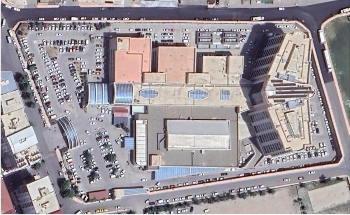
Şekil 1: Siirt Eğitim ve Araştırma Hastanesi Yerleşkesi Genel Görünümü
