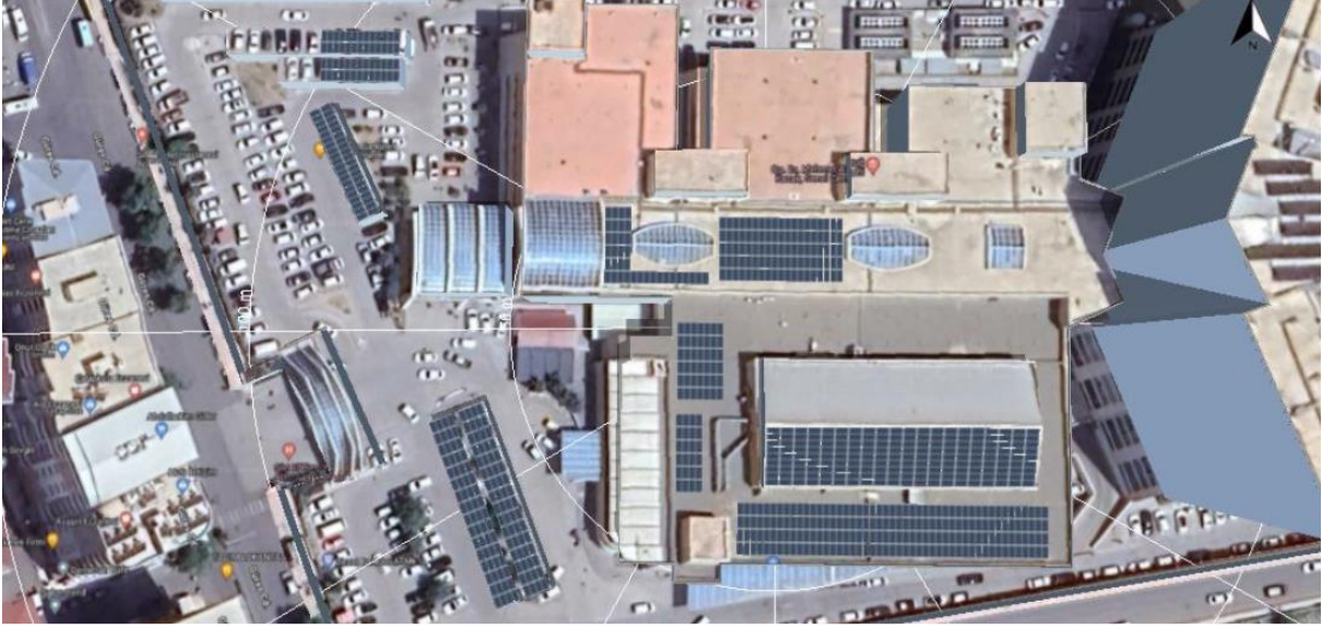
Şekil 5: Siirt Eğitim ve Araştırma Hastanesi Çatı ve Otopark Üstü PV Kurulum Tasarım Görünümü
