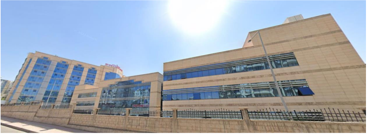
Fotoğraf 3: Siirt Eğitim ve Araştırma Hastanesi Yerleşkesi Kuzey Cephesi Görünümü
