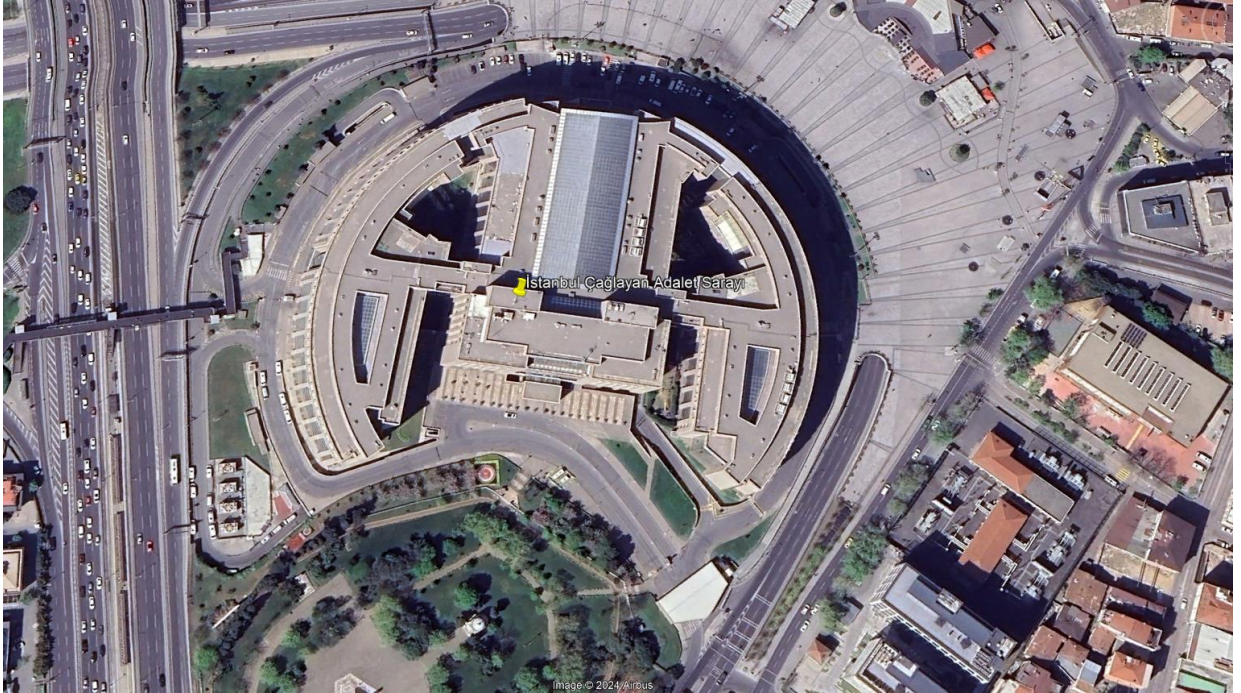
Şekil 3 İstanbul Çağlayan Adalet Sarayı Konumu
