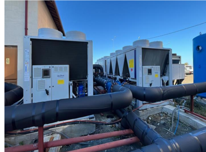
Hava Kaynaklı Isı Pompası Uygulaması
