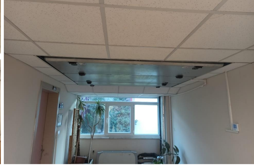
Mühendislik Fakültesi Isı Geri Kazanımlı Havalandırma Uygulaması
