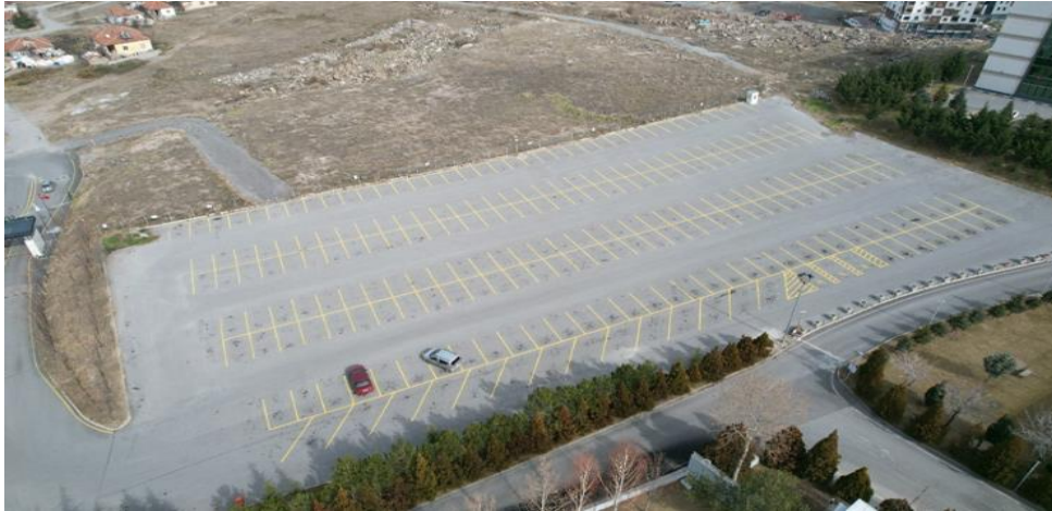
Tesisin Genel Görünüşü
