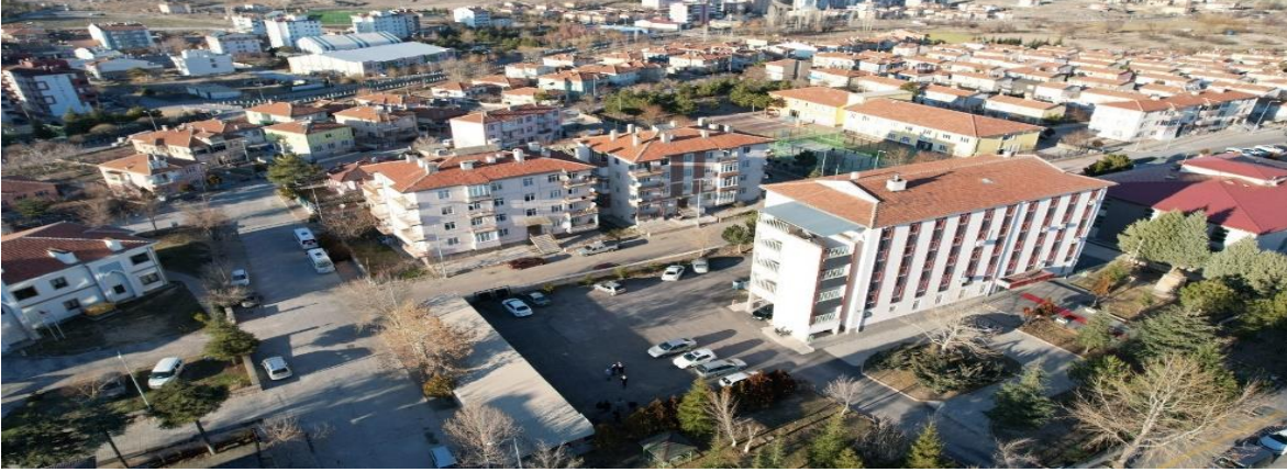
Tesisin Genel Görünüşü
