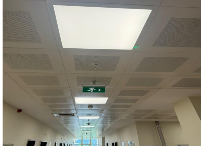
Verimsiz Armatürlerin Verimli LED Armatürler İle Değişimi
