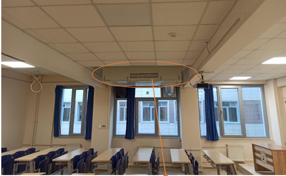
Mühendislik Fakültesi Isı Geri Kazanımlı Havalandırma Uygulaması
