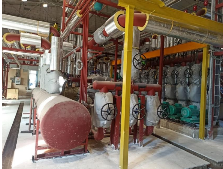
Isı merkezi kollektör ve pompa değişimi
