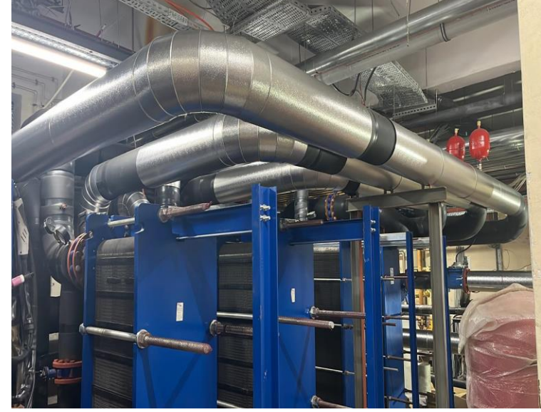
Kömür yakıtlı kazan yerine Duvar Tipi Kaskad Kazan ve Eşanjör İmalatı
