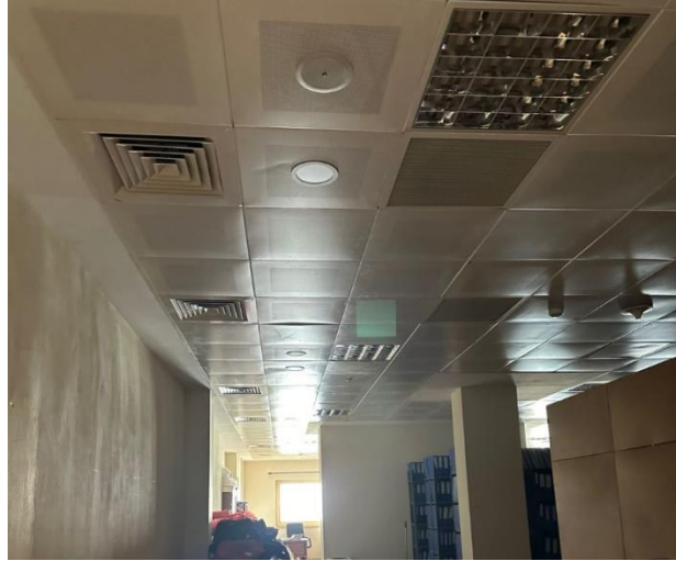
Verimsiz Armatürlerin Verimli LED Armatürler İle Değişimi
