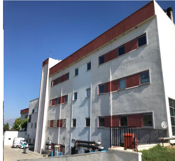
Cephede Isı Yalıtım Boya Uygulaması Pencere ve camlarının 4+16+4 argon gazlı olarak yenilenmesi
