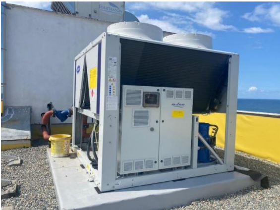
Isı Pompası Uygulaması
