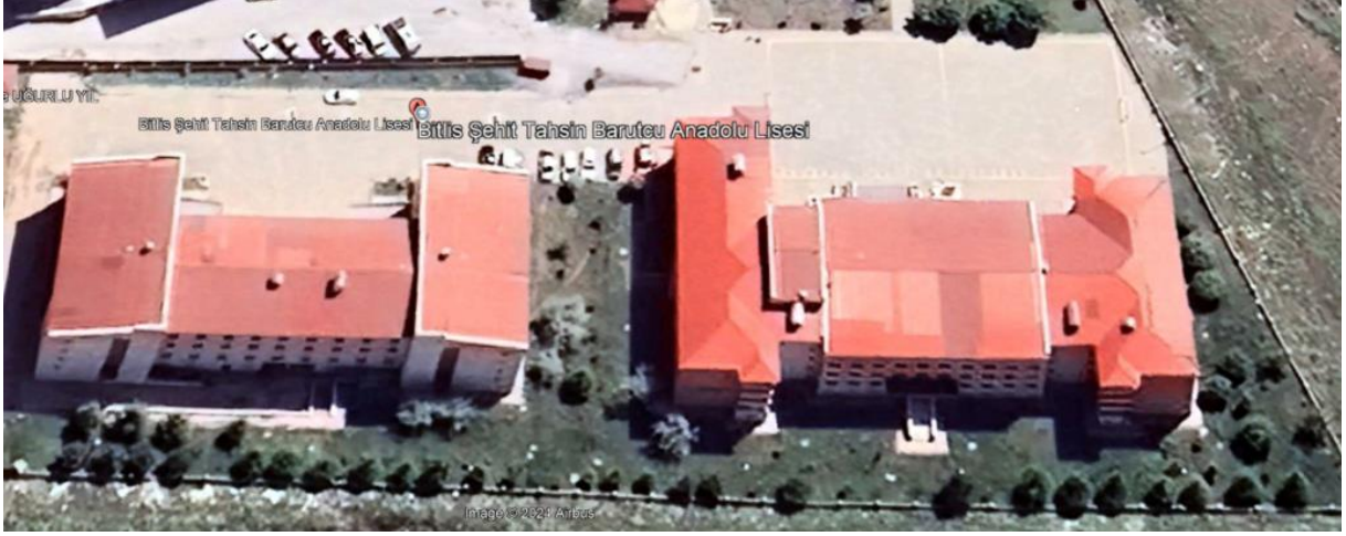
Şekil 4: Şehit Tahsin Barutçu Anadolu Lisesi -3
