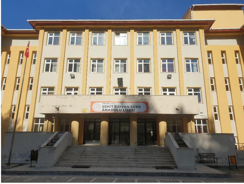
Şekil 3. Şehit Ridvan Süer Anadolu Lisesi Dış Görünüş
