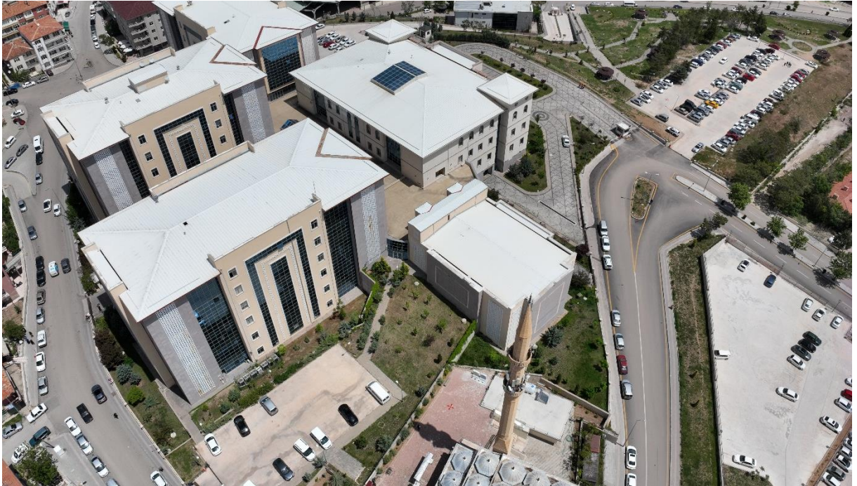
Şekil 4. Kırıkkale Valiliği Hükümet Konağı Dış Görünüş-2
