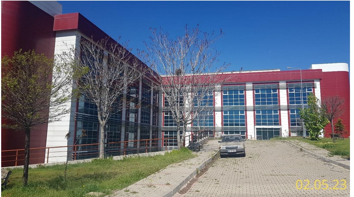
Fotoğraf 2. Kırıkkale Üniversitesi SBF ve Fizik Tedavi ve Rehabilitasyon Hastanesi Dış Görünüş
