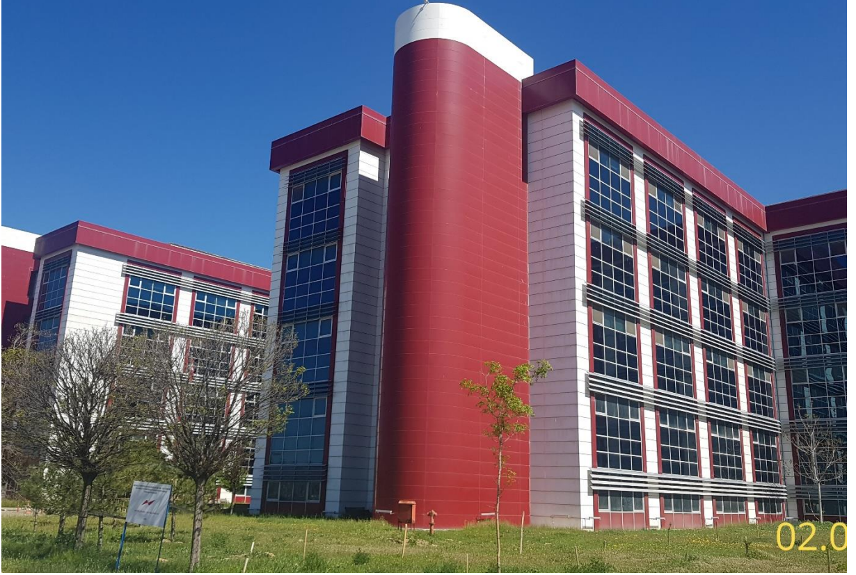
Fotoğraf 1. Kırıkkale Üniversitesi SBF ve Fizik Tedavi ve Rehabilitasyon Hastanesi Dış Görünüş
