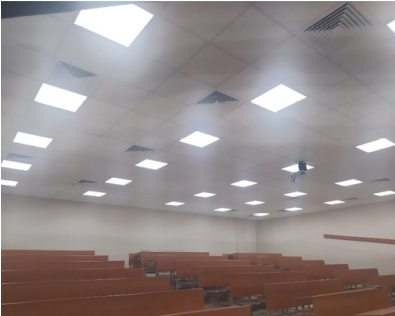
Resim 7. Eskimiş T8 Floresan ampuller ve LED aydınlatma
