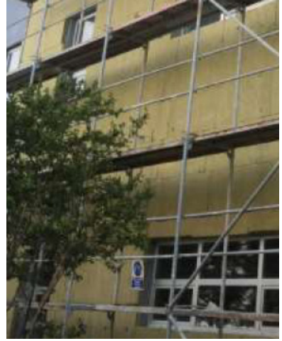
Resim 3. Bina Cephesi (Uygulama)
