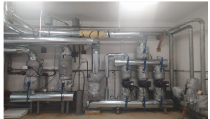
Resim 6. Sirkülasyon pompası yenilenmesi (Öncesi ve sonrası)
