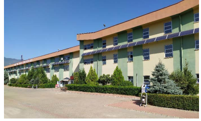
Resim 2. Bina Cephesi (Öncesi)
