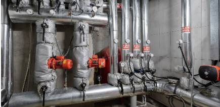
Resim 12. Isıtma otomasyon sistemi ve ilgili ekipmanlar, sensörler ve vanalar
