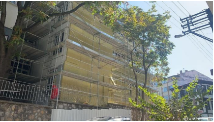
Resim 10. Bina yalıtım uygulaması
