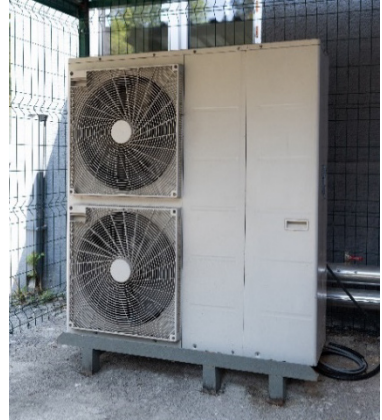
Resim 10. Güneş FV sistemi ile desteklenen ısı pompası uygulaması
