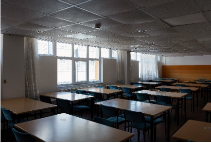
Resim 3. Bina pencereleri - Öncesi ve Sonrası
