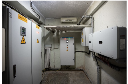
Resim 13. LED dış aydınlatma ampulü ve Kompanzasyon, ana dağıtım kontrol panellerinin değiştirilmesi
