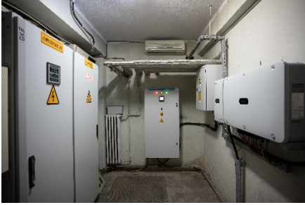
Resim 8. Kompanzasyon, ana dağıtım kontrol panellerinin değiştirilmesi
