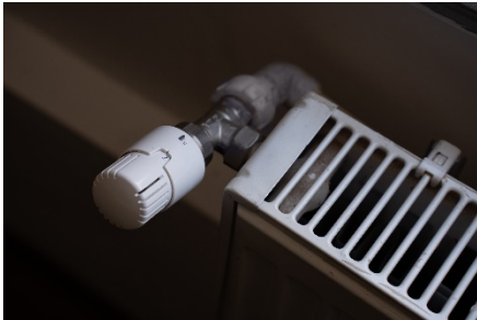
Resim 8. Termostatik Vanalar – Öncesi ve Sonrası
