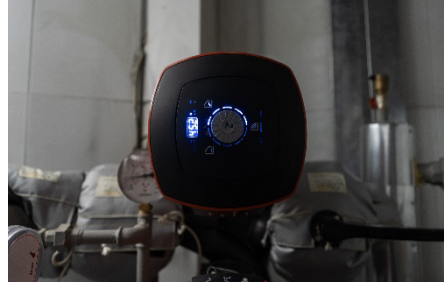
Resim 11. Isıtma otomasyon sistemi ve ilgili ekipmanlar, sensörler ve vanalar
