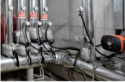
Resim 11. Isıtma otomasyon sistemi ve ilgili ekipmanlar, sensörler ve vanalar
