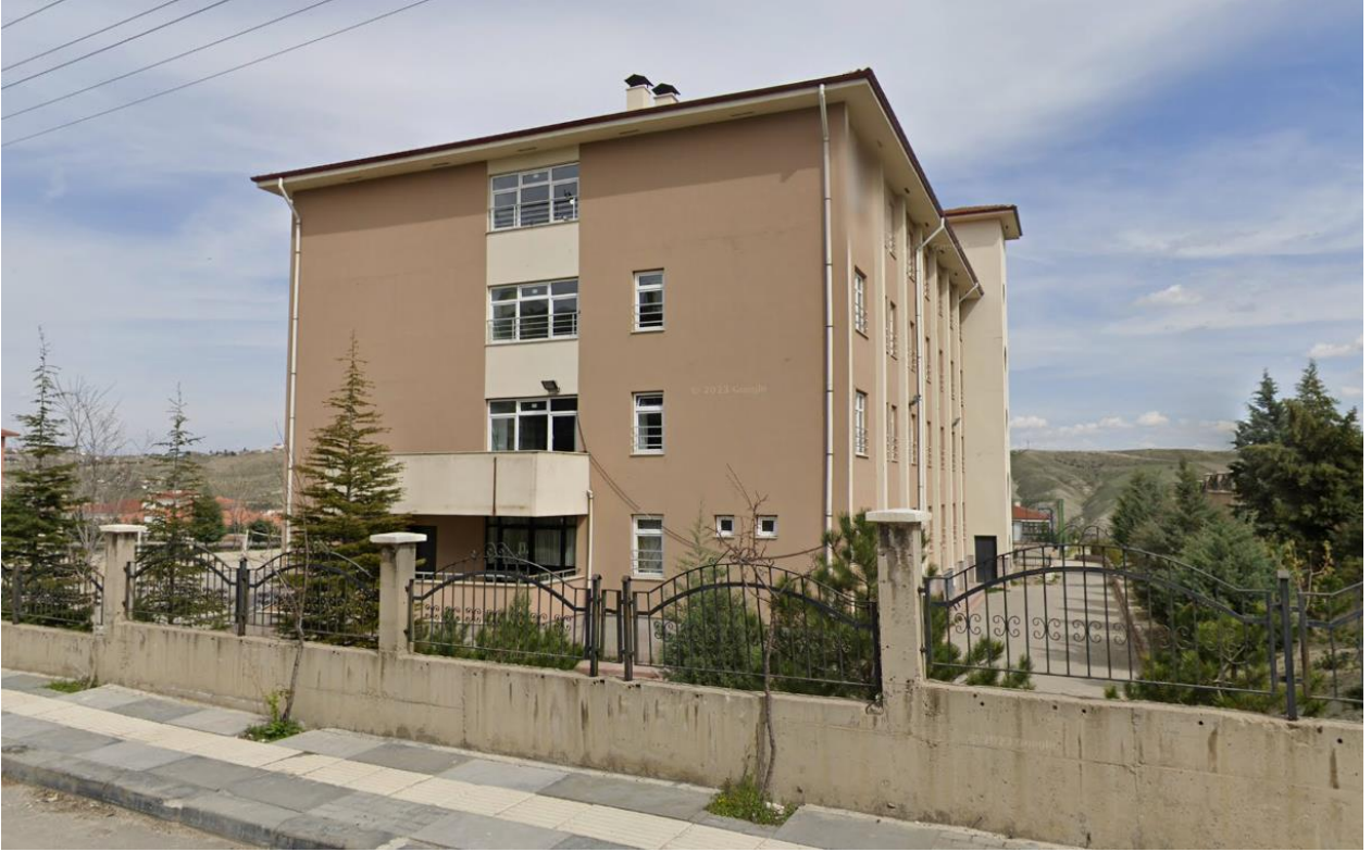
Şekil 4. Beypazarı Gazi Gündüzalp Ortaokulu Dış Görünüş-2
