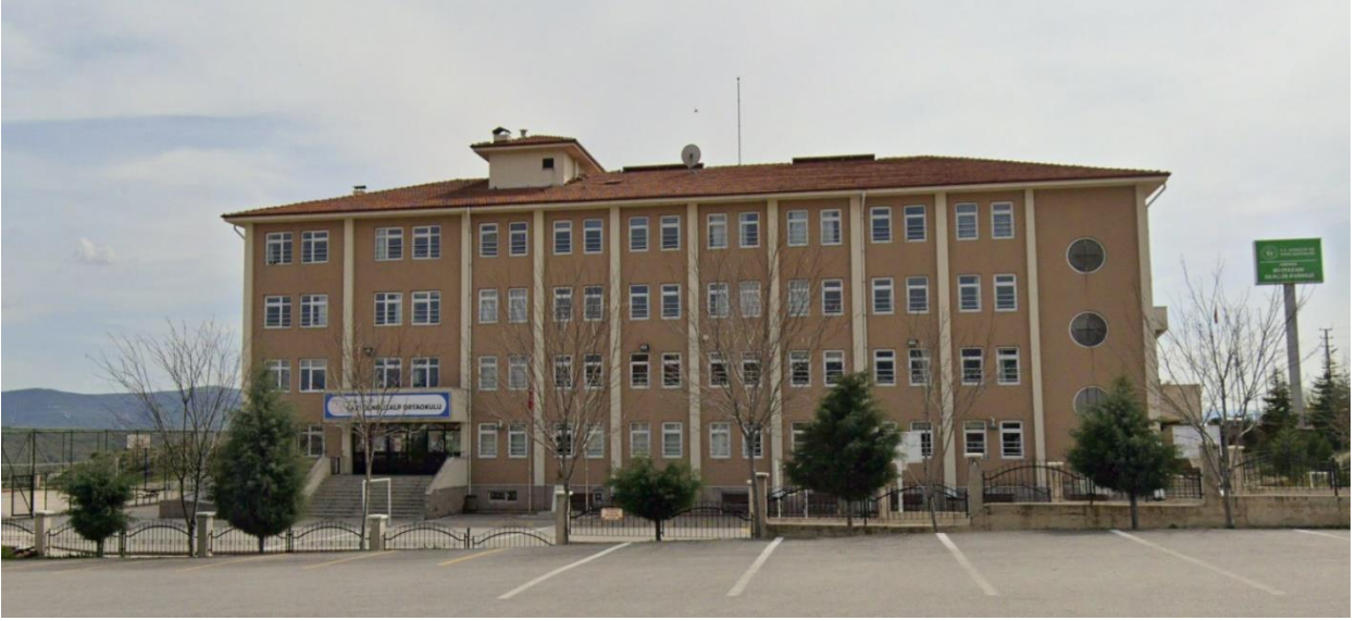
Şekil 3. Beypazarı Gazi Gündüzalp Ortaokulu Dış Görünüş-1
