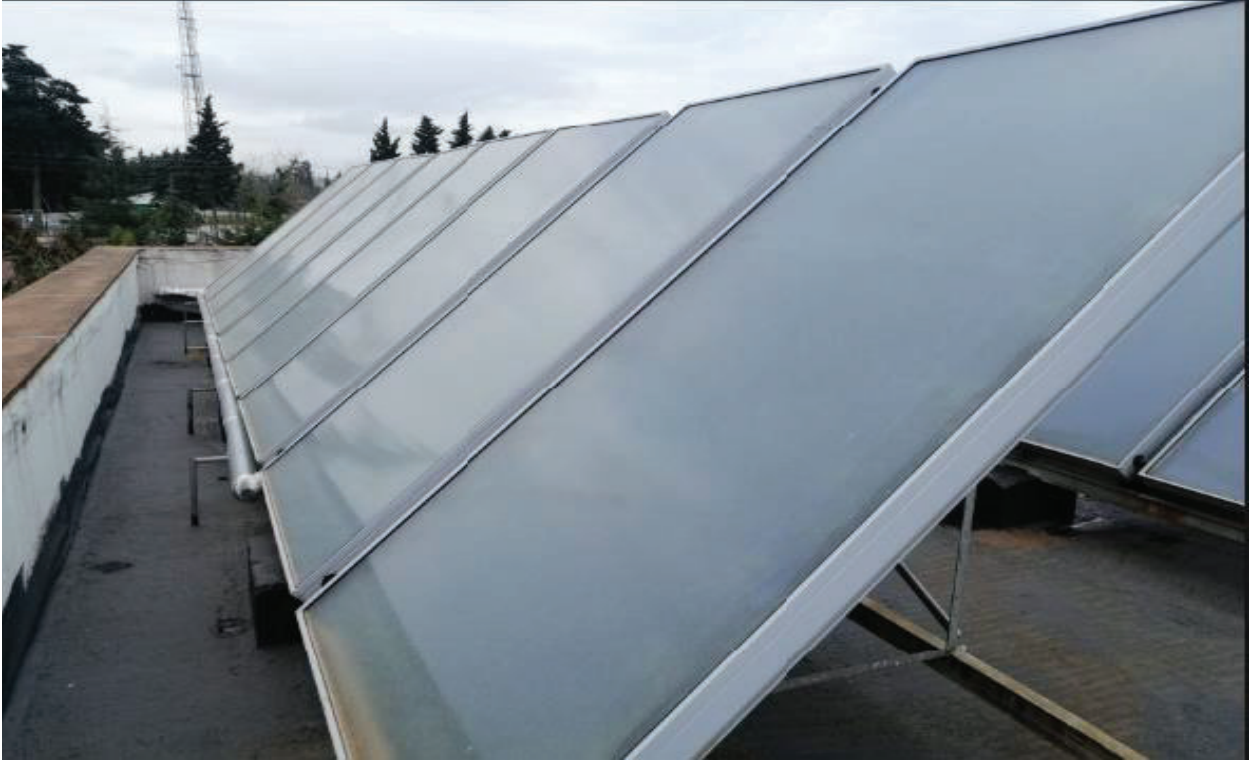
Fotoğraf 12. Doğu Karadeniz Yurt Müdürlüğü Sıcak Kullanım Suyu Ön Isıtma İçin Güneş Solar Sistemi Görünümü
