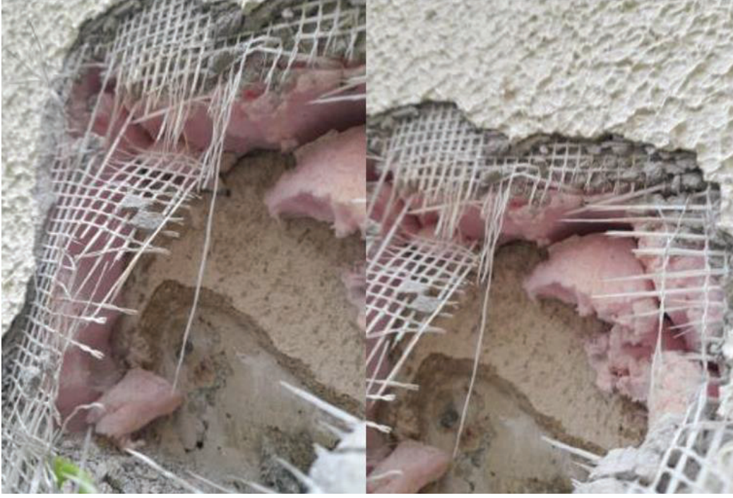
Fotoğraf 3. Rize Kaçkar Devlet Hastanesi Bina Dış Cephe Yalıtım Görünüm Örneği
