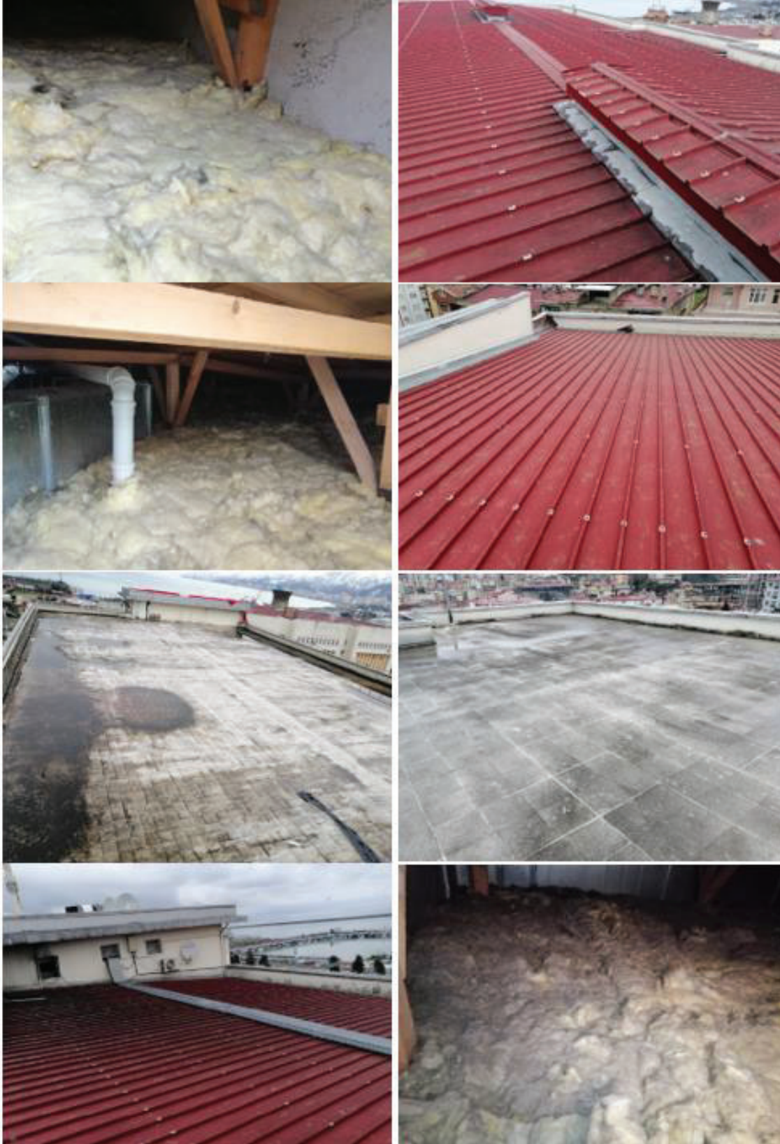
Fotoğraf 7. Rize Devlet Hastanesi Çatı Yapısı Görünümü
