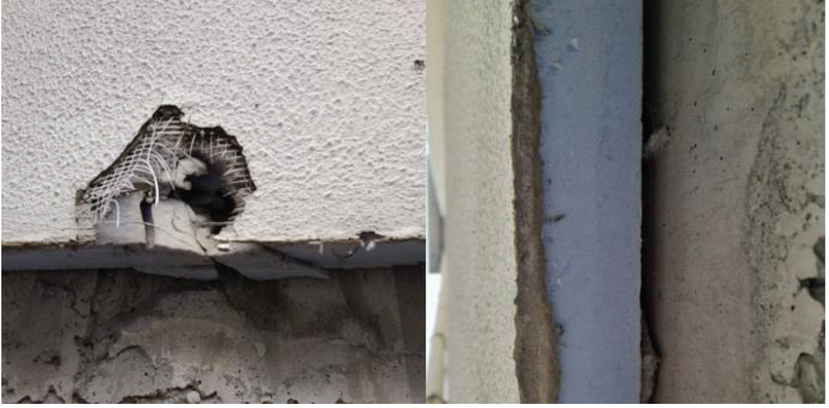
Fotoğraf 3. Rize Devlet Hastanesi Bina Dış Cephe Yalıtım Görünüm Örneği
