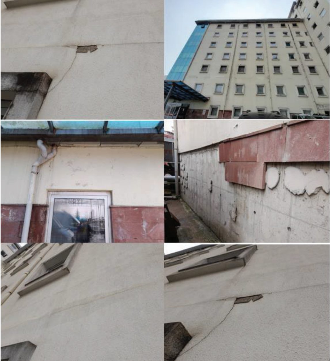
Fotoğraf 6. Rize Devlet Hastanesi Dış Cephe Bozulma Örnekleri
