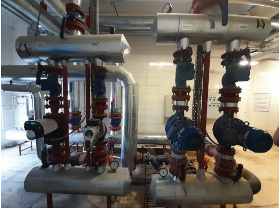
Fotoğraf 10. Giresun Üniversitesi, Fen Edebiyat Fakültesi, İktisadi ve İdari Bilimler Fakültesi Kazan Isıtma Sistemi Pompaları Görünümü
