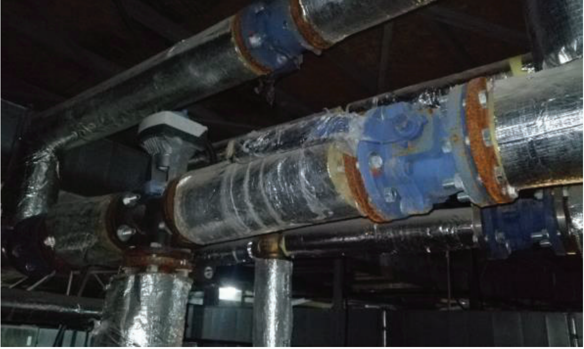
Fotoğraf 11. Giresun Şebinkarahisar Devlet Hastanesi Klima santrali Isıtma Bataryası 3 Yollu Vana Görünümü
