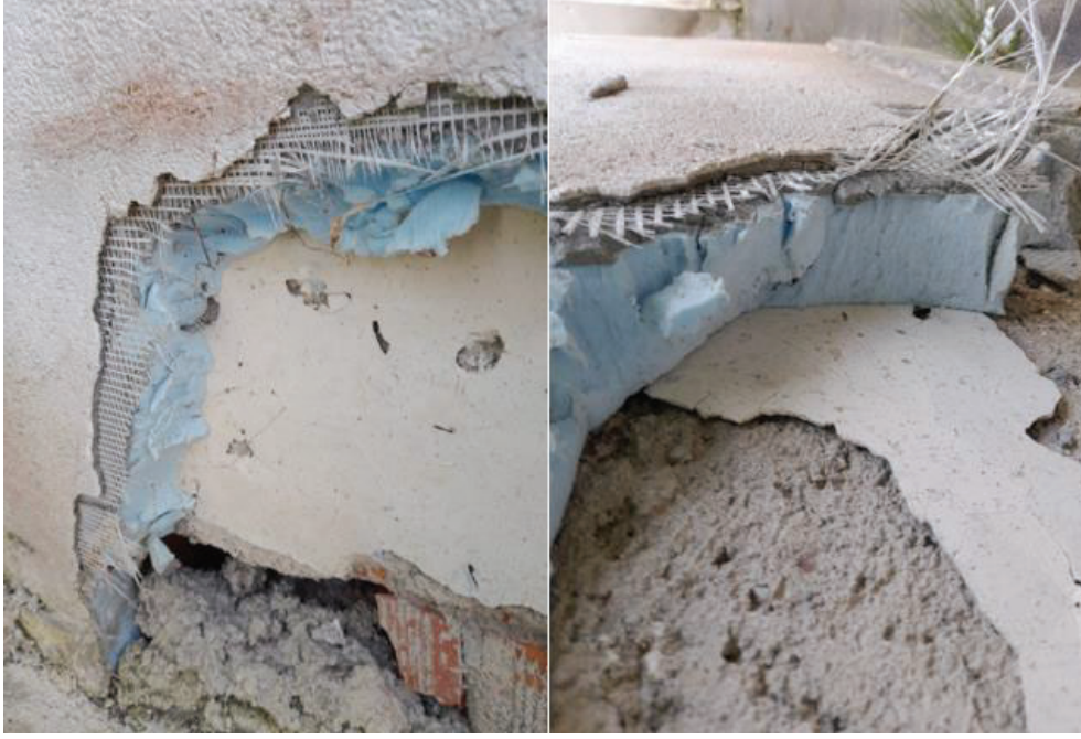
Fotoğraf 3. Giresun Üniversitesi, Fen Edebiyat Fakültesi, İktisadi ve İdari Bilimler Fakültesi Dış Cephe Yalıtım Görünüm Örnekleri
