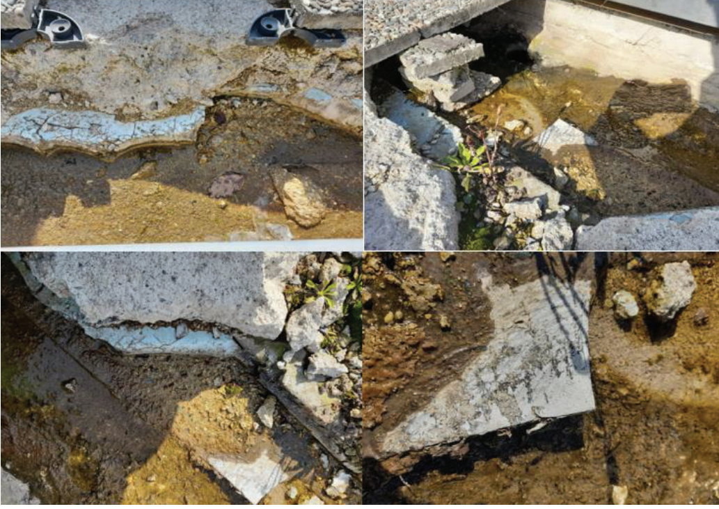
Fotoğraf 6. Giresun Üniversitesi, Fen Edebiyat Fakültesi, İktisadi ve İdari Bilimler Fakültesi Teras Yapısındaki Su Yalıtımı Bozulma Örnekleri
