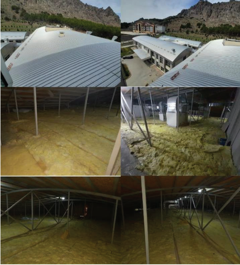
Fotoğraf 6. Giresun Şebinkarahisar Devlet Hastanesi çatı Yapısı ve Yalıtımı Görünümü
