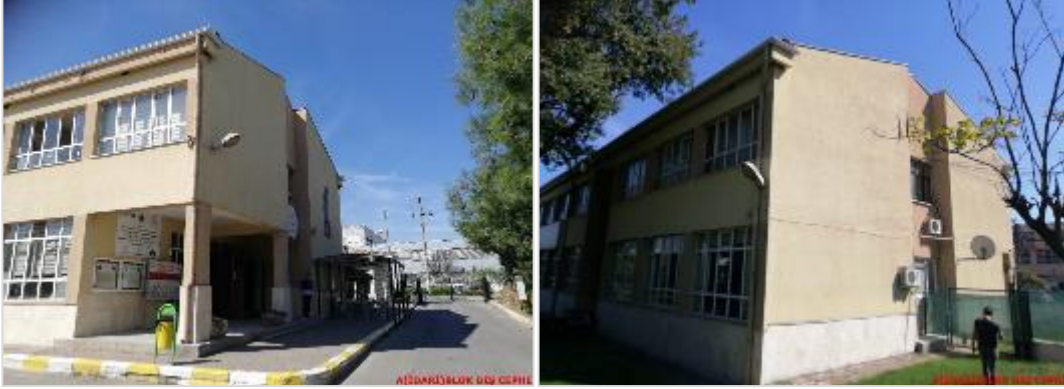
Fotoğraf 1 Bursa Atatürk Mesleki ve Teknik Anadolu Lisesi A Blok Binası GörSELLERİ
