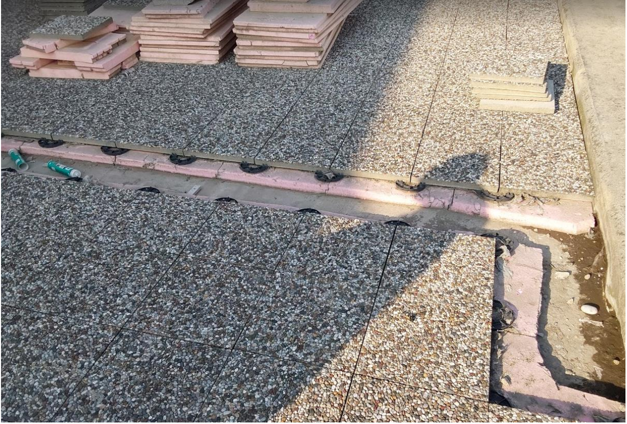
Fotoğraf 6. İstanbul Çağlayan Adalet Sarayı Tavan Yapı Birleşen Göstergeleri
