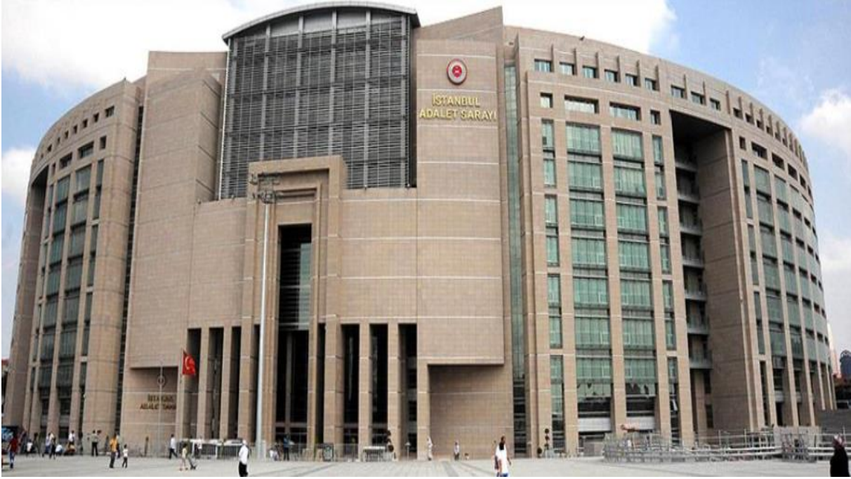
Şekil 3. İstanbul Çağlayan Adalet Sarayı Görünümü
