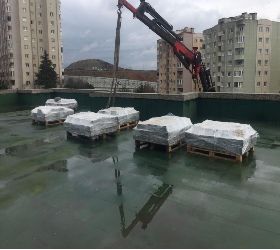
Fotoğraf 10. PV Panellerin Çatıya Taşınması-Örnek
