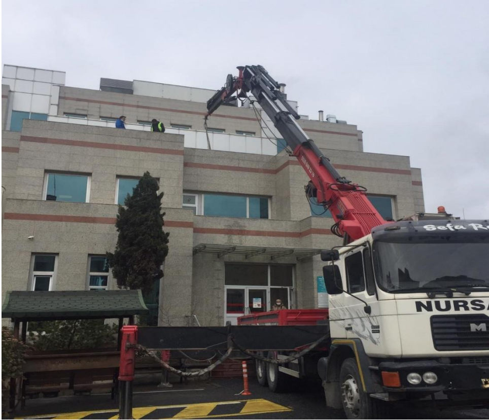
Fotoğraf 9. PV Panellerin Çatıya Taşınması-Örnek
