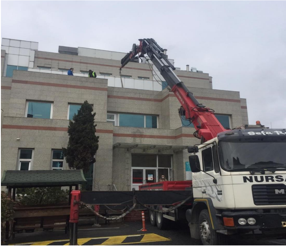
Fotoğraf 6. PV Panellerin Çatıya Taşınması-Örnek
